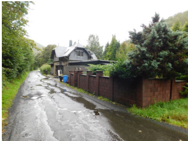
IP25 - Bahnhofsweg 1, 57520 Schutzbach
