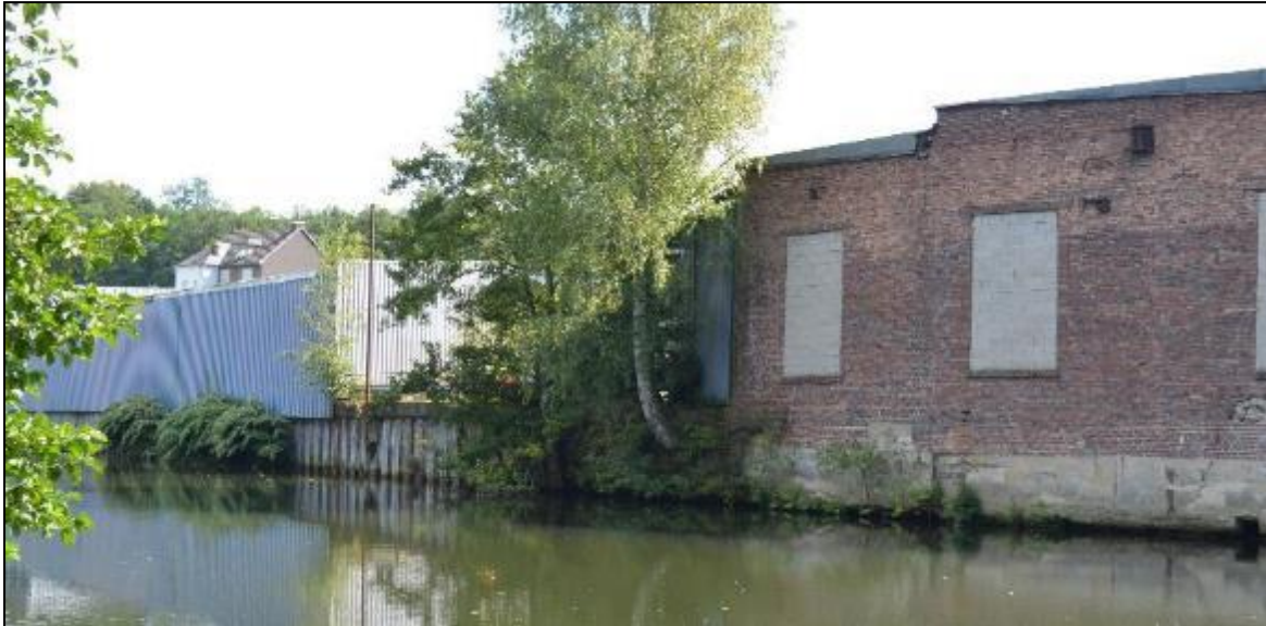
Abbildung 15: Gebäudebestand unmittelbar oberhalb des Wehres
