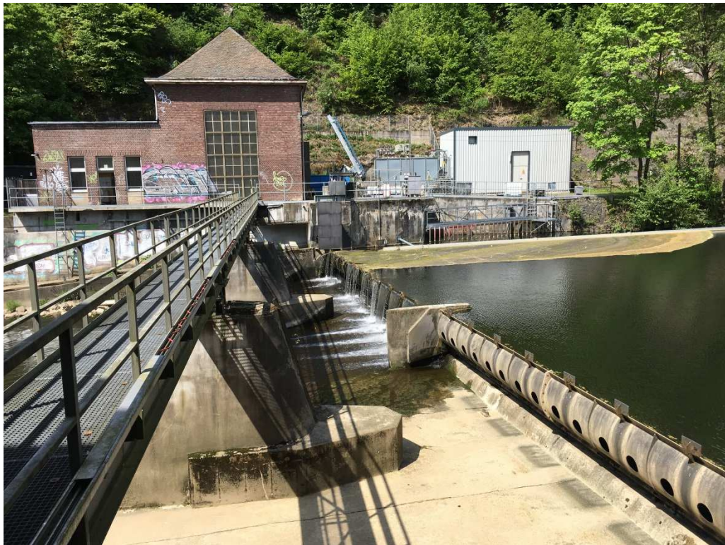
Bild 1: bestehende Wehr- und Wasserkraftanlage Scheuerfeld
