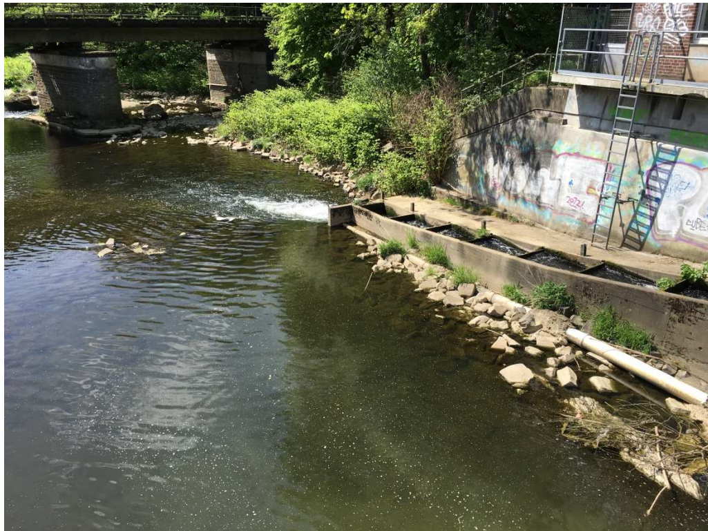
Bild 4: Auslauf Fischaufstieg
