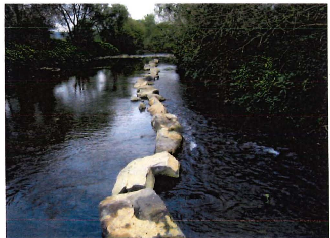
Bild 1: Diffuser bei ca. 2 MNQ (Eintritt Mühlengraben von rechts, Eintrittswinkel ca. 80°) (Foto: J. Schneider)
