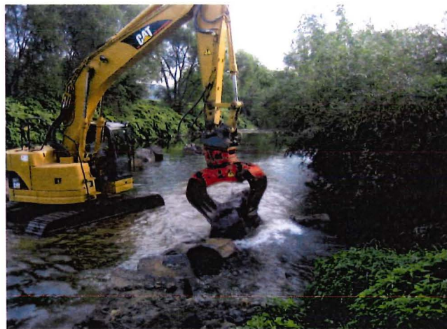
Bild 3: Setzen der Einzelsteine
