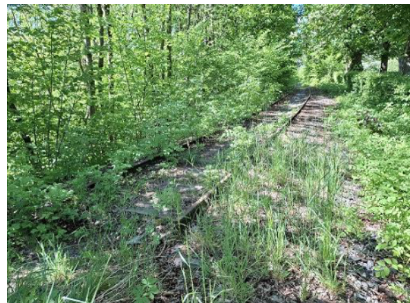
Abbildung 330: Gleise im Bereich des gemeindlichen Friedhofes mit Blick in Richtung Westen
