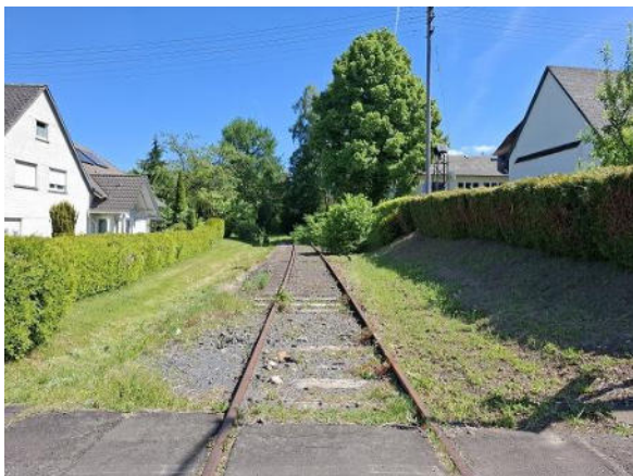
Abbildung 329: Gleise im Bereich der Straße Im Elbbachtal mit Blick in Richtung Südosten
