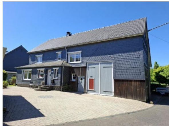
Abbildung 107: Ursprüngliche dörfliche Baustruktur mit Scheune / Stall als Einfirsthaus in der Kirchstraße / L 286
