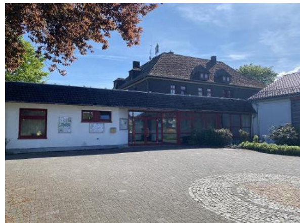
Abbildung 223: Rückwärtiger Teil des Bürgerhauses
