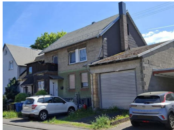
Abbildung 133: Erheblicher Verschönerungs- / Sanierungsbedarf an Wohn- und Nebengebäude in der Hildburgstraße / K 116
