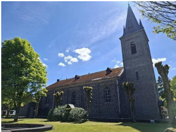
Abbildung 289: Nordseite der Kirche
