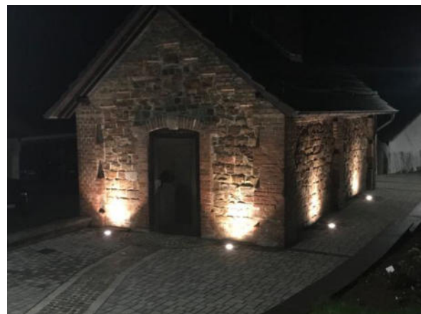
Abbildung 318: Beispiel Backes Beleuchtung
