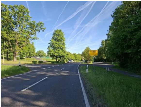
Abbildung 340: Ortseingang an der Betzdorfer Straße / L 287
