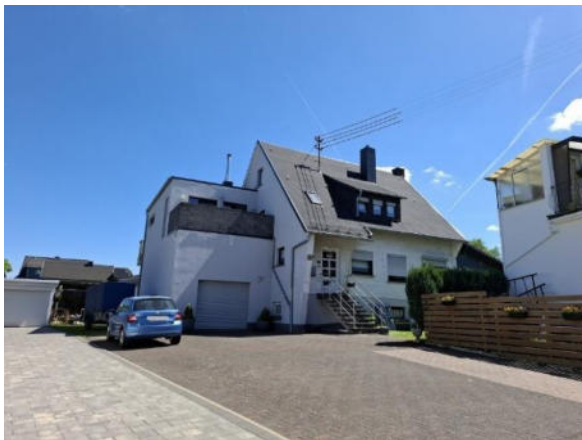
Abbildung 112: Überprägte Altbauung in der Marienberger Straße / L 287 I
