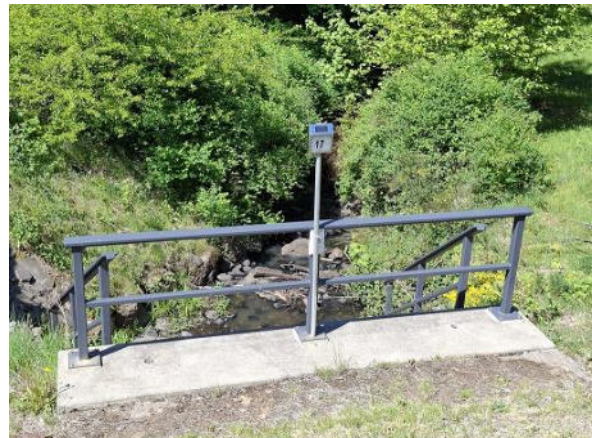
Abbildung 51: Elbbach westlich der Betzdorfer Straße / L 287
