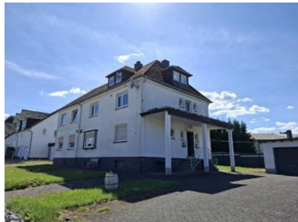
Abbildung 115: Überprägte Altbauung in der Naurother Straße / K 113
