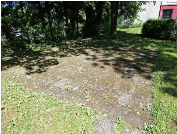
Abbildung 268: Vermooste Pflasterfläche I
