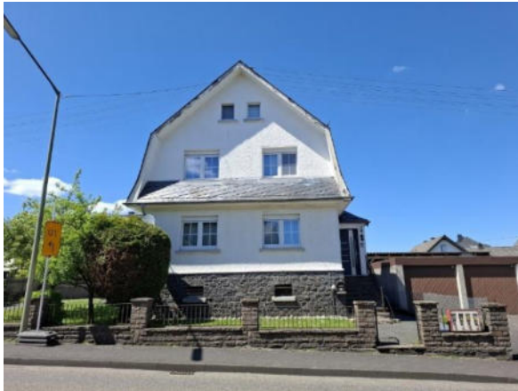
Abbildung 99: Massivhaus mit Mansardgiebeldach und Sichtmauerwerk aus Naturstein in der Marienberger Straße / L 287
