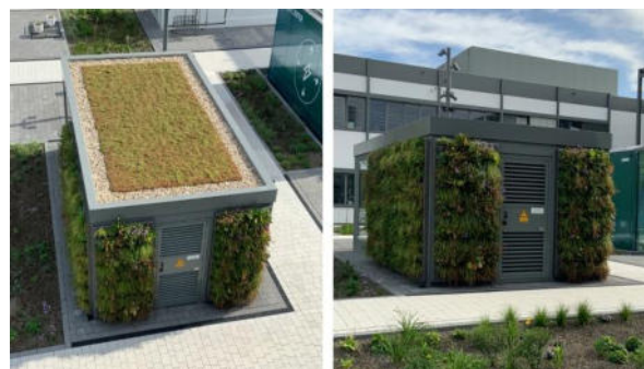
Abbildung 207: Beispiel eines begrünten Transformatorgebäudes Quelle: https://mobilane.com/app/uploads/2024/02/Mobilane-MobiPanelBetonbau-Fassadenbegrunung-1200x600-1.jpg
