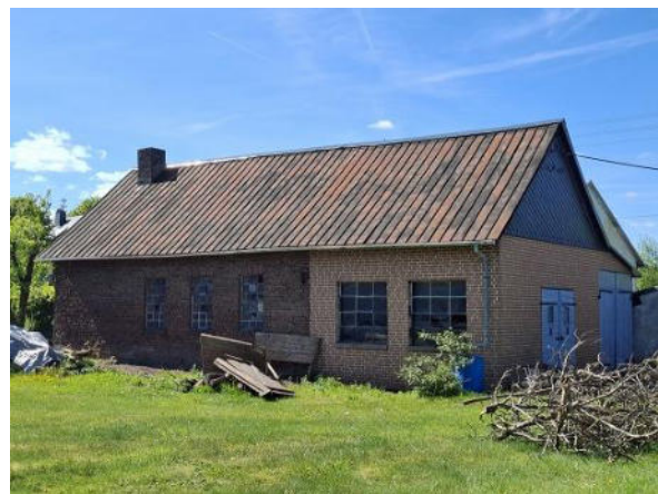
Abbildung 101: Sichtmauerwerk aus Ziegelstein im Schmiedeweg
