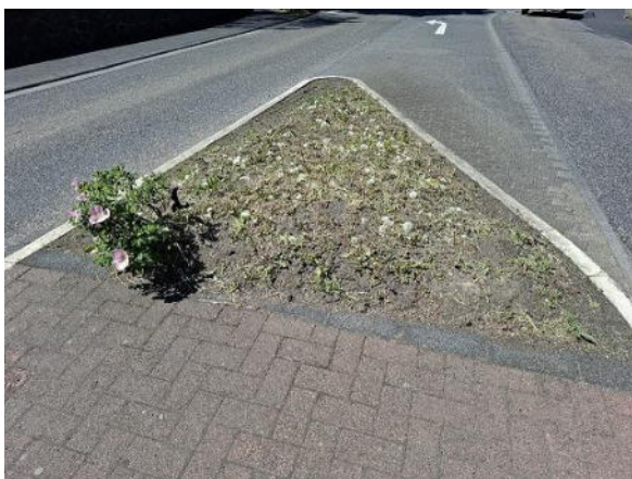
Abbildung 185: Beet im Fahrbahnnteiler auf der Betzdorfer Straße / L 287 zwischen Kirche und Bäckerei ohne Bepflanzung
