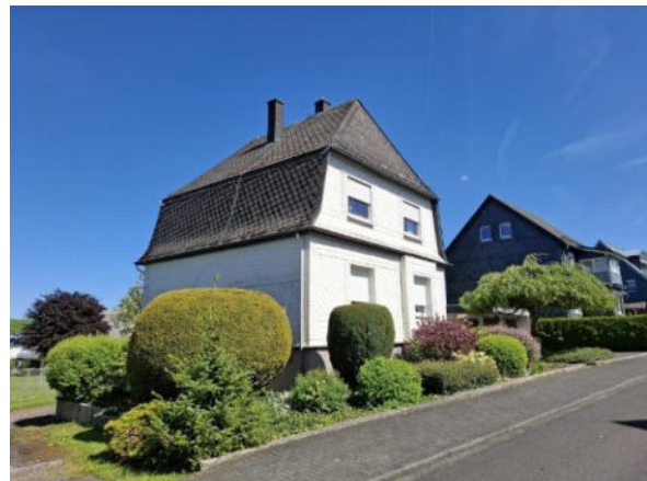
Abbildung 103: Mansarddach mit Schopf in der Altbahnstraße
