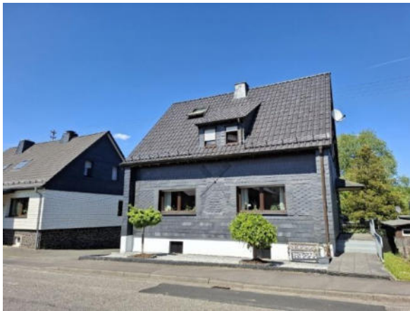
Abbildung 116: Fassadenverkleidung aus Naturschiefer in der Hildburgstraße / K 116
