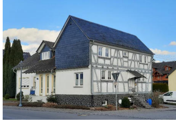
Abbildung 205: Beispiel des heruntergekommenen Hauses in einem Ortskern nach einer umfassenden Sanierung
