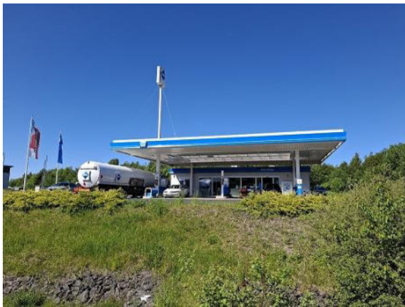
Abbildung 18: Tankstelle im Gewerbegebiet in der Nordstraße
