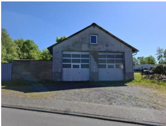
Abbildung 132: Verschönerungs- / Sanierungsbedarf im Gewerbegebiet im Alsdorfer Weg
