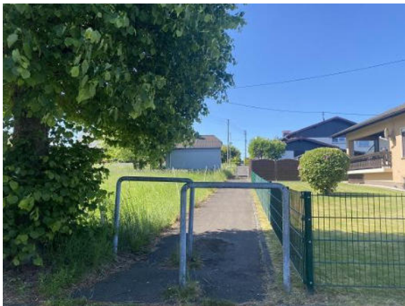
Abbildung 362: Fußweg zwischen Finkenweg und Löhstraße
