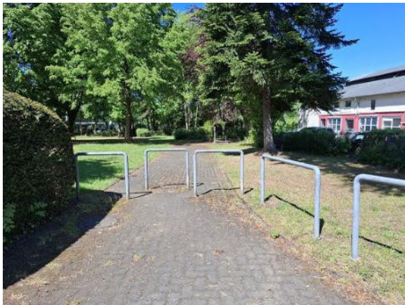
Abbildung 266: Absperrbögen am Canisiusplatz zur Betzdorfer Straße / L 287
