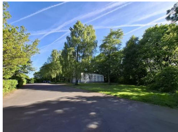
Abbildung 284: Trauerhalle mit Parkplatz
