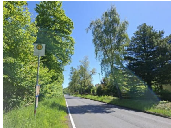
Abbildung 335: Bushaltestelle an der Weitefelder Straße / L 286 östlich der Ausfahrt Auwiese
