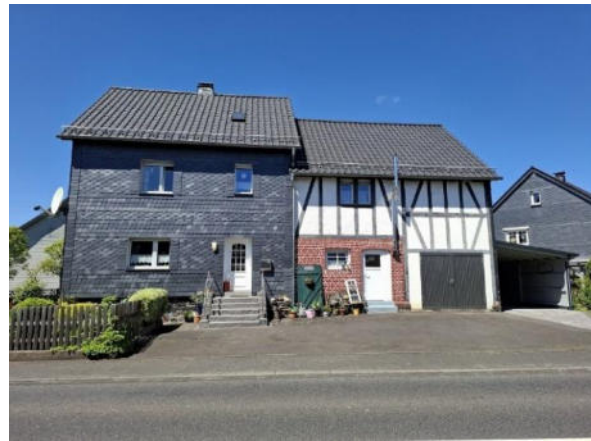
Abbildung 105: Ursprüngliche dörfliche Baustruktur mit Scheune / Stall als Einhaus in der Kirchstraße / L 286
