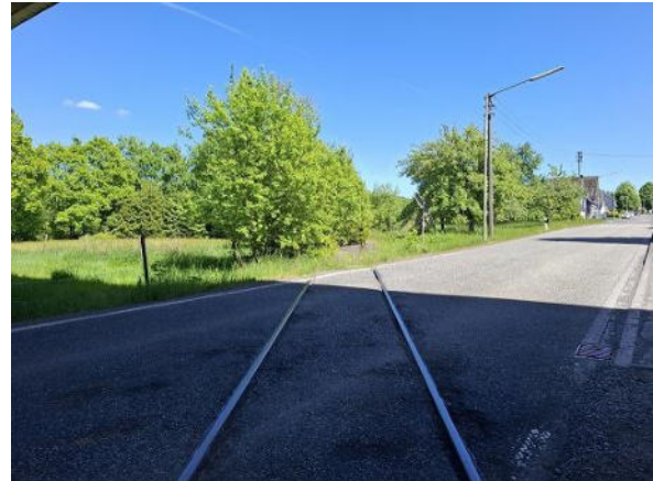
Abbildung 326: Gleise im Bereich der Hildburgstraße / K 116 mit Blick in Richtung Osten / Ortslage
