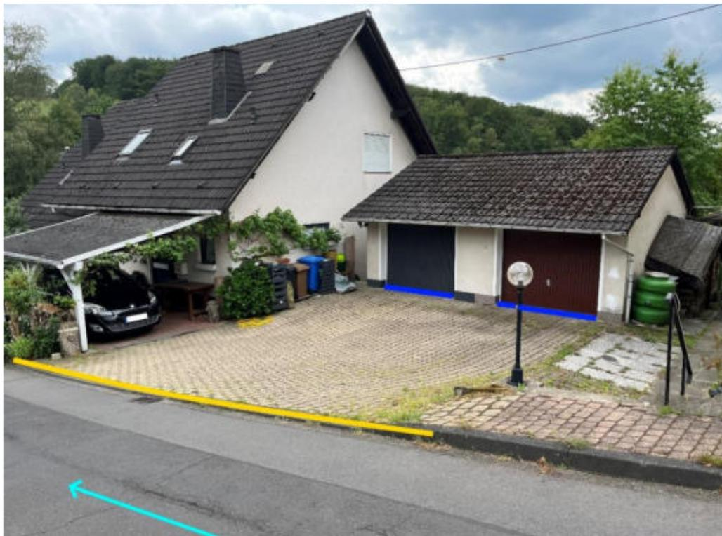
Abbildung 86: Notabflussweg "Zum Antenborn" mit Fließweg (hellblau), Objektschutzmaßnahmen (blau) und Bordanlagen (gelb)
