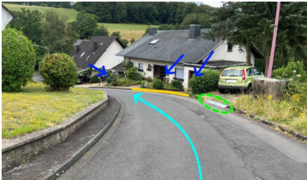
Abbildung 84: Notabflussweg "Zum Antenborn" mit Fließweg (hellblau), Objektschutzmaßnahmen (blau), Instandhaltung der Entwässerungsanlage und Bordanlagen (gelb)
