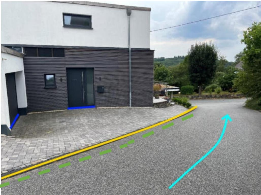
Abbildung 93: Notabflussweg "Zum Höfesgarten" mit Fließweg (hellblau), Objektschutzmaßnahmen (blau) und Entwässerungsrinne (grün)
