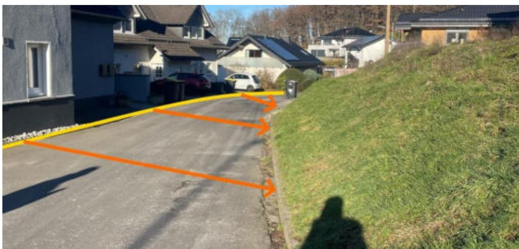
Abbildung 116: Notabflussweg "Mittelbuschstraße" mit Bordanlagen (gelb) und Neigungswechsel der Fahrbahn (orange)
