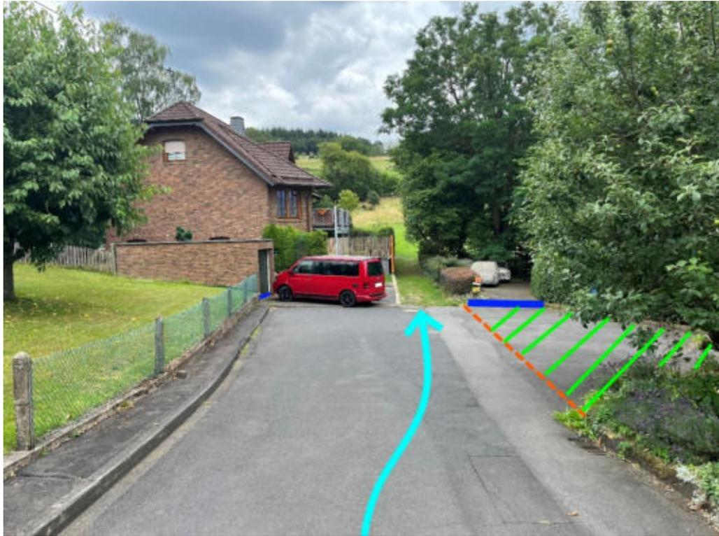
Abbildung 89: Notabflussweg "Zum Antenborn" mit Fließweg (hellblau), Objektschutzmaßnahmen (blau), Aufwallung (orange) und Senke (grün)
