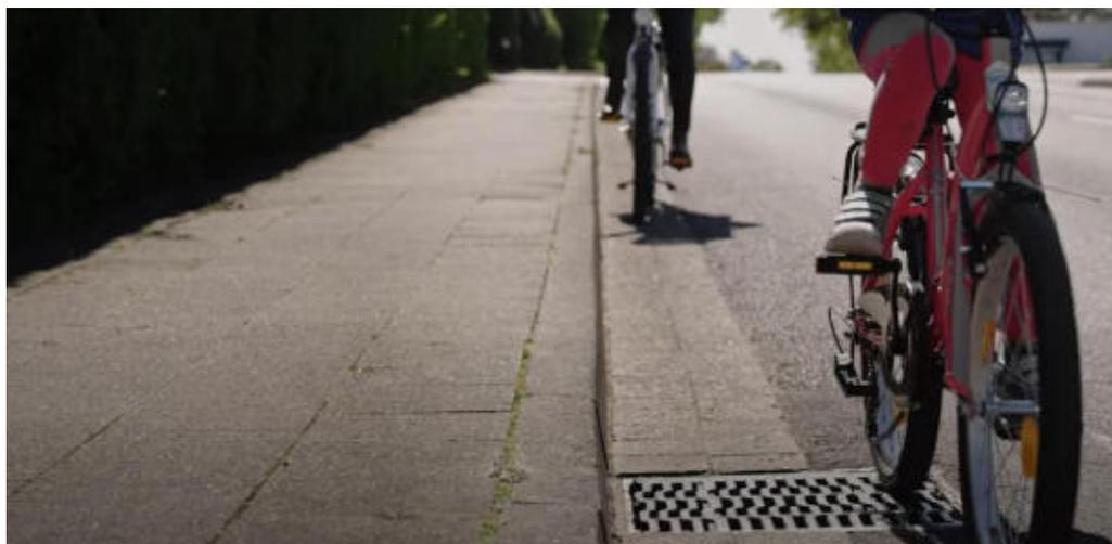
Abbildung 120: Beispiel für die Sonderform des Straßenablaufes, hier: Meidrain Gitterrost (Bildquelle: <https://www.youtube.com/watch?v=kaNeWCDonFY>)
