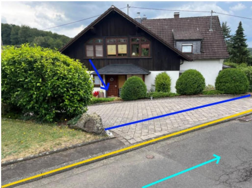
Abbildung 80: Notabflussweg " Dellstraße " mit Fließweg (hellblau), Objektschutzmaßnahmen (blau) und Bordanlagen (gelb)
