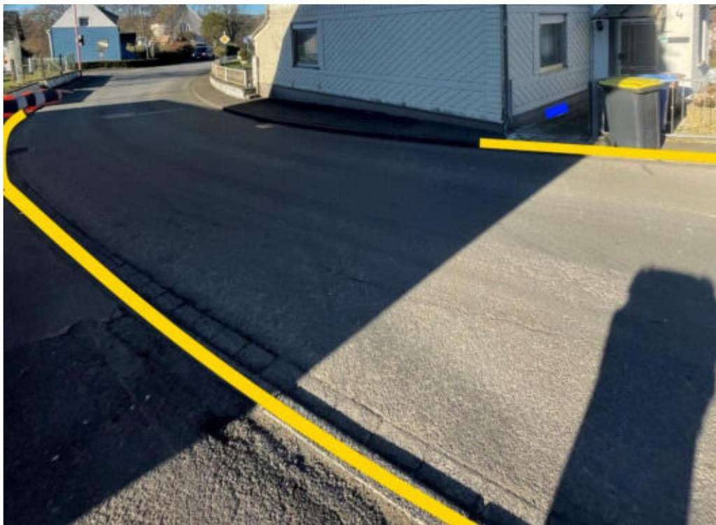
Abbildung 66: Notabflussweg " Kohlhardtstraße " mit Objektschutzmaßnahmen (blau) und Bordanlagen (gelb)
