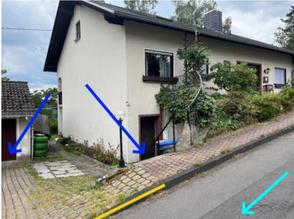
Abbildung 87: Notabflussweg "Zum Antenborn" mit Fließweg (hellblau), Objektschutzmaßnahmen (blau) und Bordanlagen (gelb)
