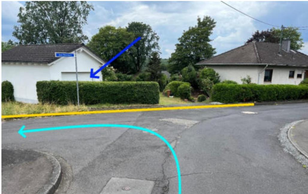
Abbildung 83: Notabflussweg "Dellstraße" mit Fließweg (hellblau), Objektschutzmaßnahmen (blau), Bordanlagen (gelb) und Kreuzung mit „Zum Antenborn“
