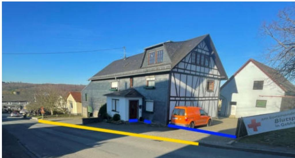
Abbildung 61: Notabflussweg " Kohlhardtstraße " mit Objektschutzmaßnahmen (blau) und Bordanlagen (gelb)
