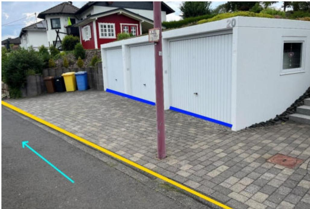
Abbildung 70: Notabflussweg " Dellstraße " mit Fließweg (hellblau), Objektschutzmaßnahmen (blau) und Bordanlagen (gelb)
