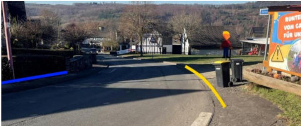
Abbildung 59: Notabflussweg "Kohlhardtstraße" mit Objektschutzmaßnahmen (blau) und Bordanlagen (gelb)
