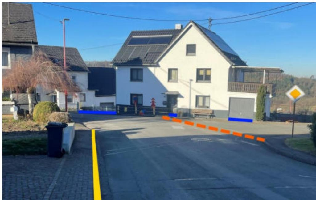
Abbildung 63: Notabflussweg " Kohlhardtstraße " mit Objektschutzmaßnahmen (blau), Aufwallung (orange) und Bordanlagen (gelb)
