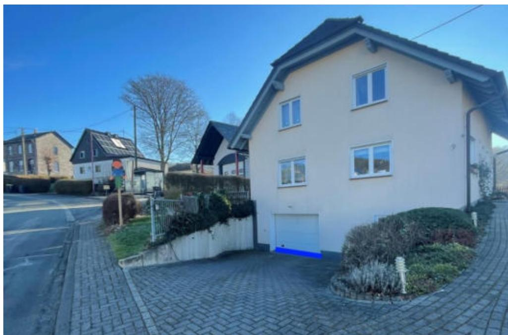
Abbildung 64: Notabflussweg " Kohlhardtstraße " mit Objektschutzmaßnahmen (blau) und Bordanlagen (gelb)
