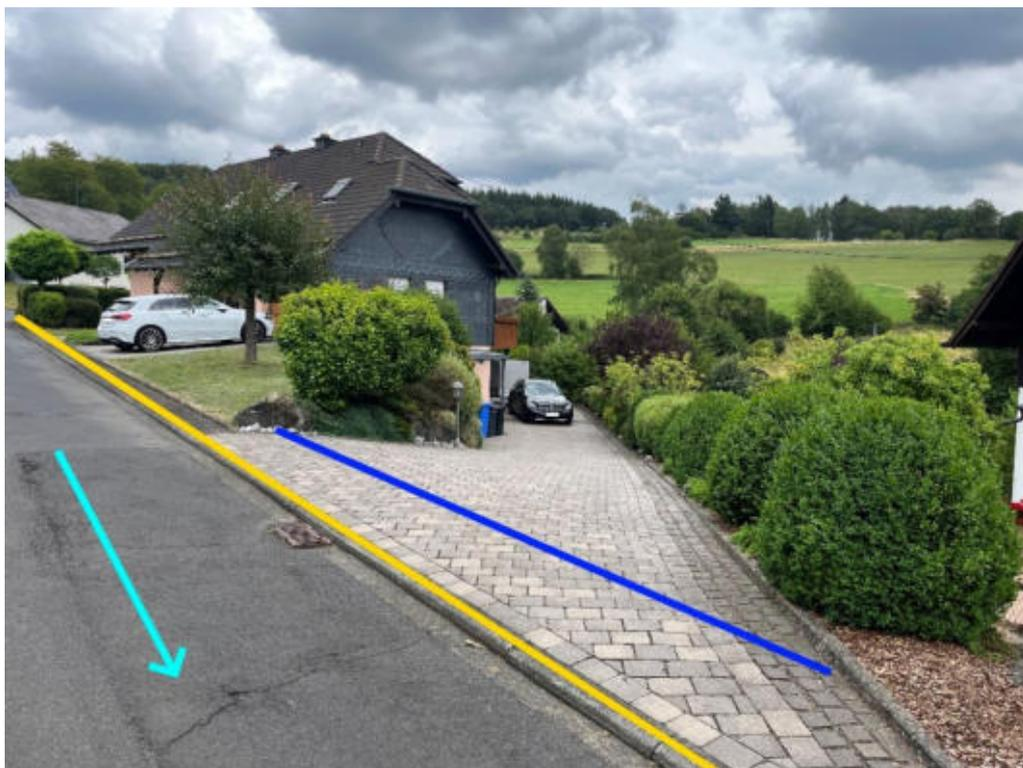
Abbildung 81: Notabflussweg " Dellstraße " mit Fließweg (hellblau), Objektschutzmaßnahmen (blau) und Bordanlagen (gelb)
