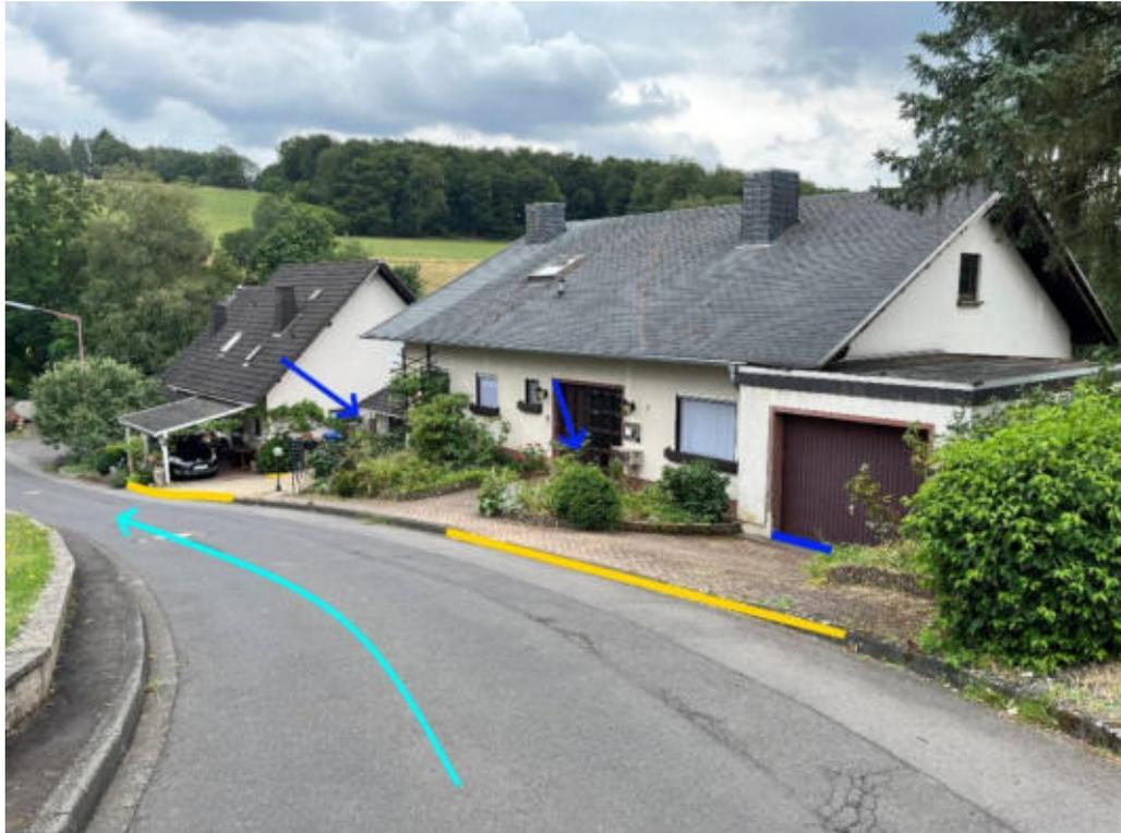
Abbildung 85: Notabflussweg "Zum Antenborn" mit Fließweg (hellblau), Objektschutzmaßnahmen (blau) und Bordanlagen (gelb)
