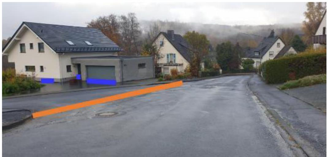
Abbildung 56: Notfließweg Struthofstraße mit Verwallung (orange) und Objektschutzmaßnahmen (blau)
