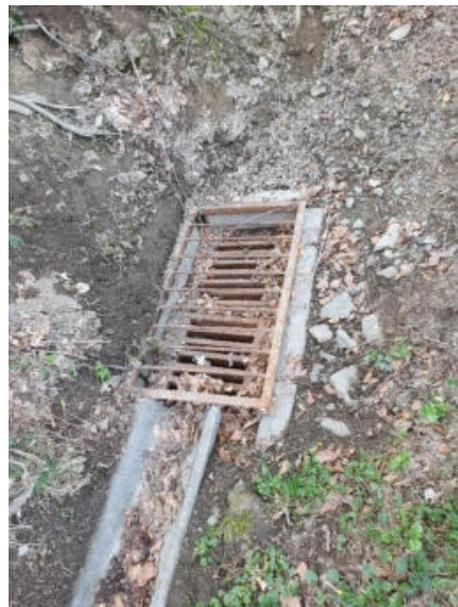
Abbildung 25 und Abbildung 26: Graben oberhalb Bebauung und Einlaufbauwerk bei Trockenheit
