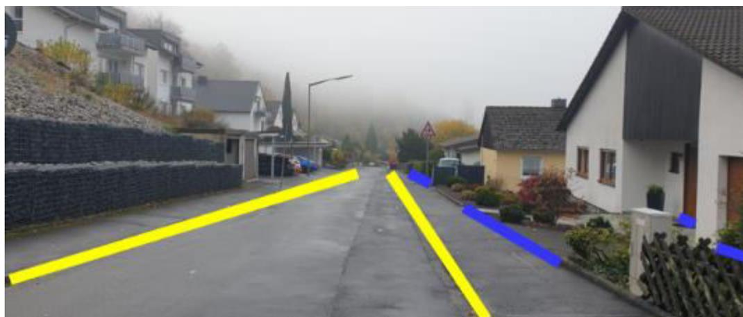
Abbildung 61: Notfließweg nördlicher Eisenweg Bordanlagen (gelb) und Objektschutzmaßnahmen (blau)
