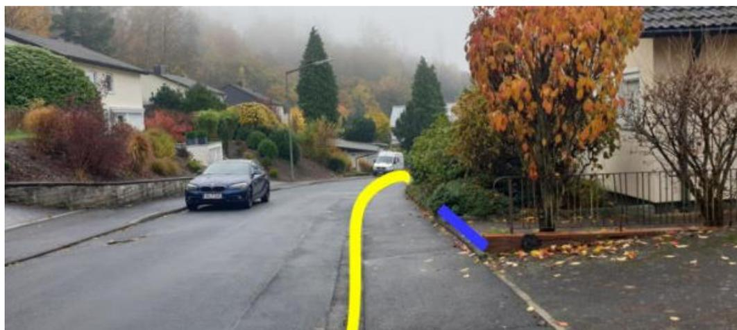
Abbildung 63: Notfließweg nördlicher Eisenweg Bordanlagen (gelb) und Objektschutzmaßnahmen (blau)
