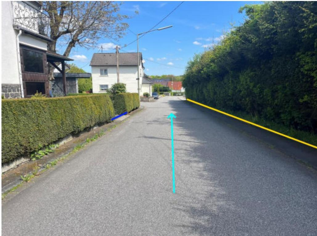
Abbildung 86: Notabflussweg "Ringstraße" mit Fließrichtung (hellblau), Objektschutzmaßnahmen (dunkelblau) und Bordanlagen (gelb)
