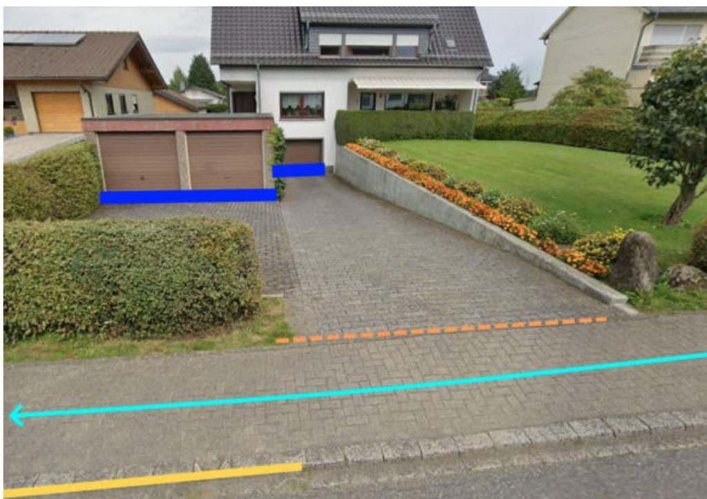
Abbildung 111: Notabflussweg "Marienbergerstraße" mit Fließrichtung (hellblau), Objektschutzmaßnahmen (dunkelblau), Aufwällung (orange) und Bordanlagen (gelb)
