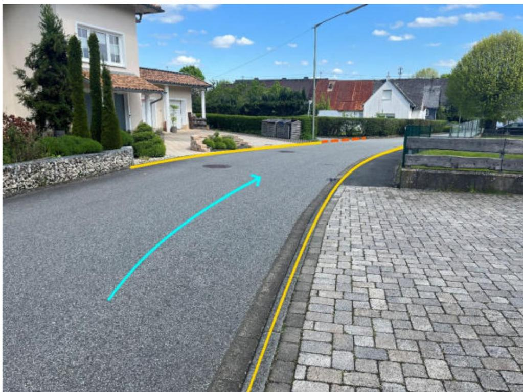
Abbildung 90: Notabflussweg "Ringstraße" mit Fließrichtung (hellblau), Objektschutzmaßnahmen (dunkelblau) und Bordanlagen (gelb)
