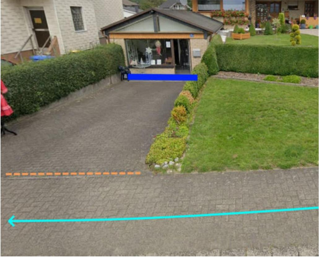
Abbildung 113: Notabflussweg "Marienbergerstraße" mit Fließrichtung (hellblau), Objektschutzmaßnahmen (dunkelblau) und Aufwallung (orange)
