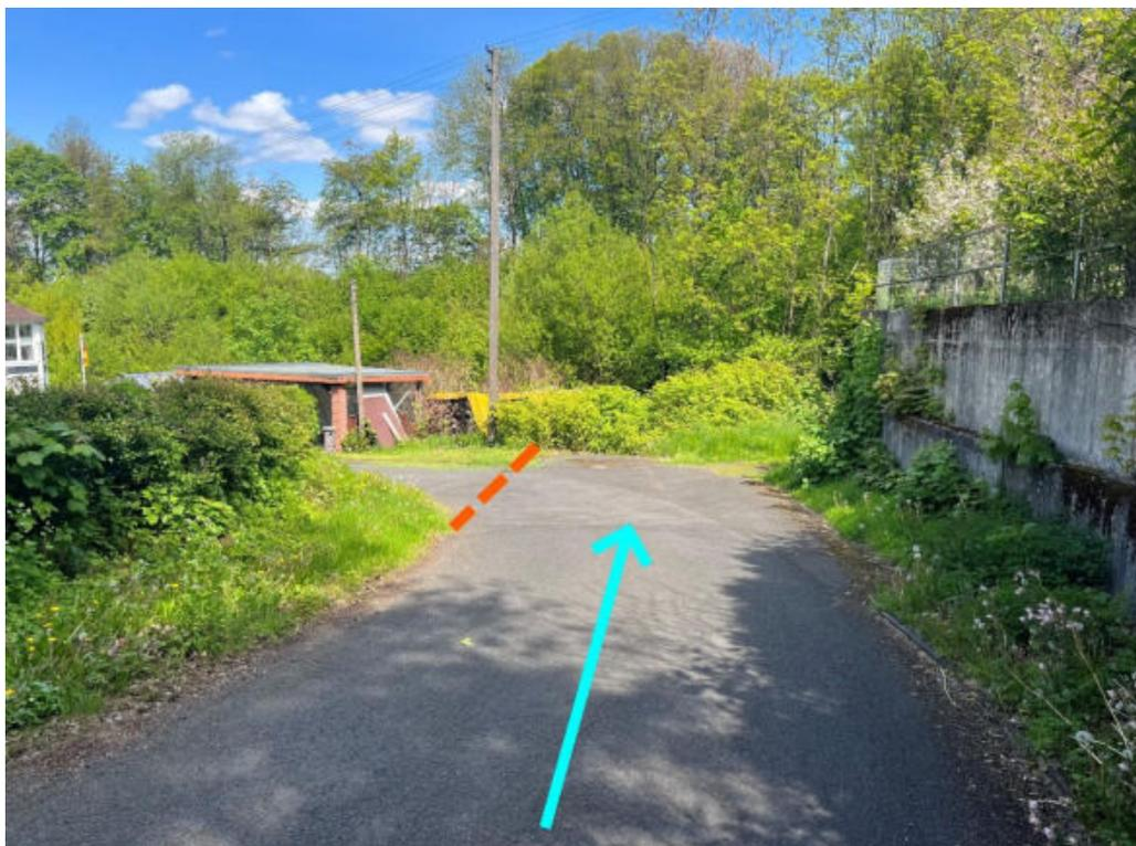
Abbildung 105: Notabflussweg "Ringstraße" mit Fließrichtung (hellblau) und Aufwallung (orange)
