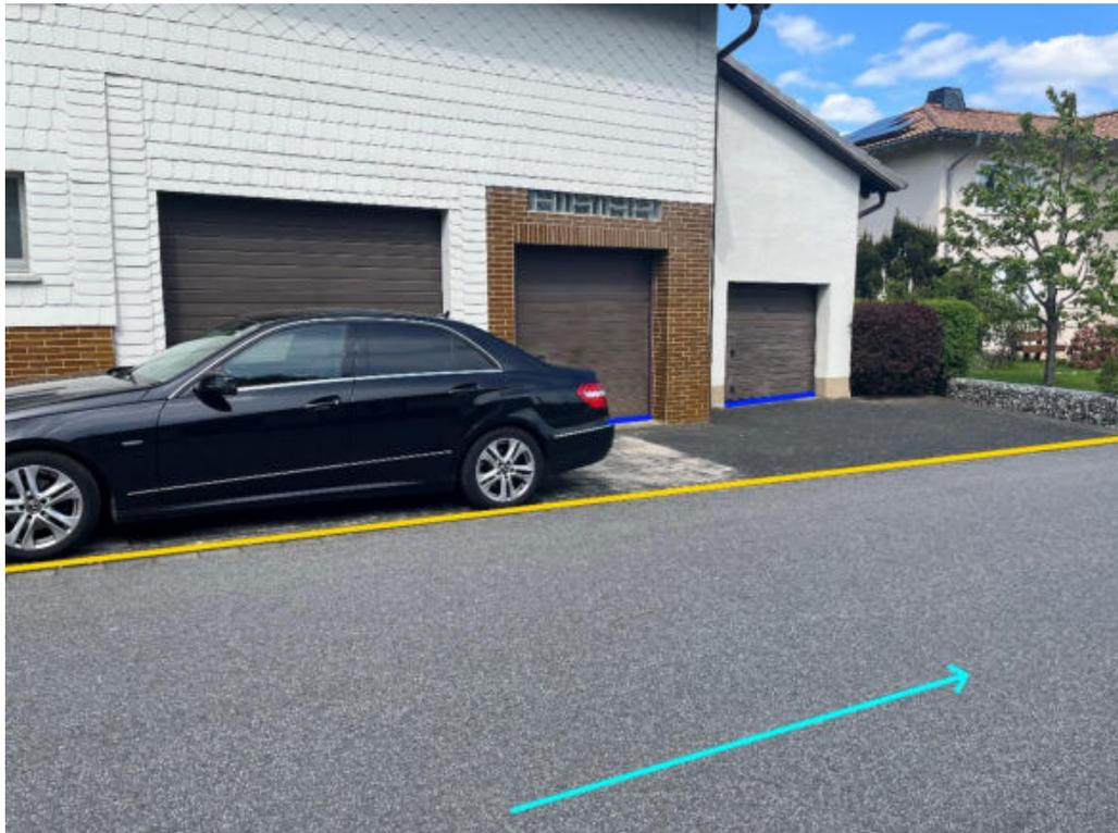
Abbildung 88: Notabflussweg "Ringstraße" mit Fließrichtung (hellblau), Objektschutzmaßnahmen (dunkelblau) und Bordanlagen (gelb)
