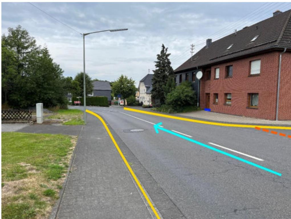
Abbildung 70: Notabflussweg "Weitefelder Straße" mit Fließrichtung (hellblau), Objektschutzmaßnahmen (dunkelblau), Aufwallung (orange) und Bordanlagen (gelb)
