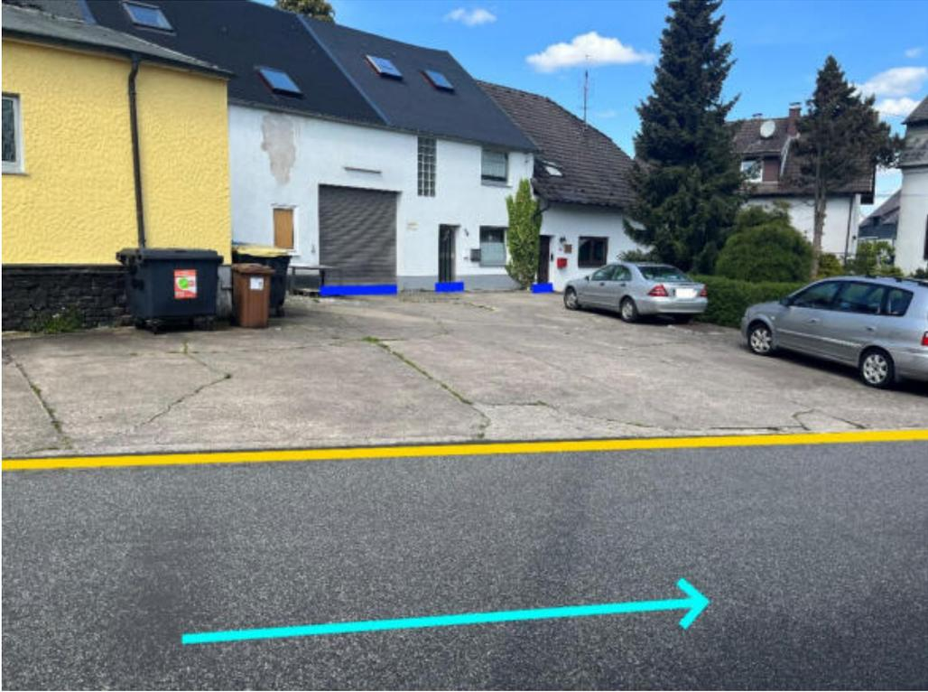
Abbildung 85: Notabflussweg "Ringstraße" mit Fließrichtung (hellblau), Objektschutzmaßnahmen (dunkelblau) und Bordanlagen (gelb)
