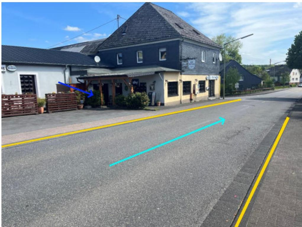
Abbildung 82: Notabflussweg "Ringstraße" mit Fließrichtung (hellblau), Objektschutzmaßnahmen (dunkelblau) und Bordanlagen (gelb)
