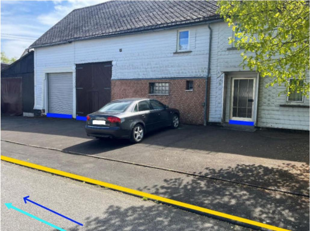
Abbildung 94: Notabflussweg "Ringstraße" mit Fließrichtung (hellblau), Objektschutzmaßnahmen (dunkelblau) und Bordanlagen (gelb)
