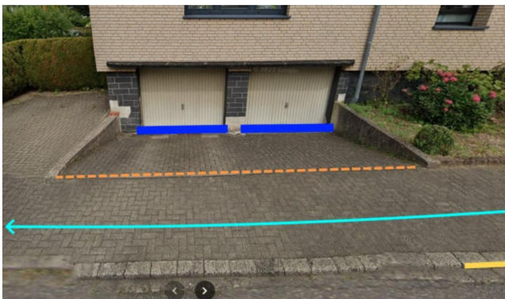
Abbildung 117: Notabflussweg "Marienbergerstraße" mit Fließrichtung (hellblau), Objektschutzmaßnahmen (dunkelblau), Aufwallung (orange) und Bordanlagen (gelb)
