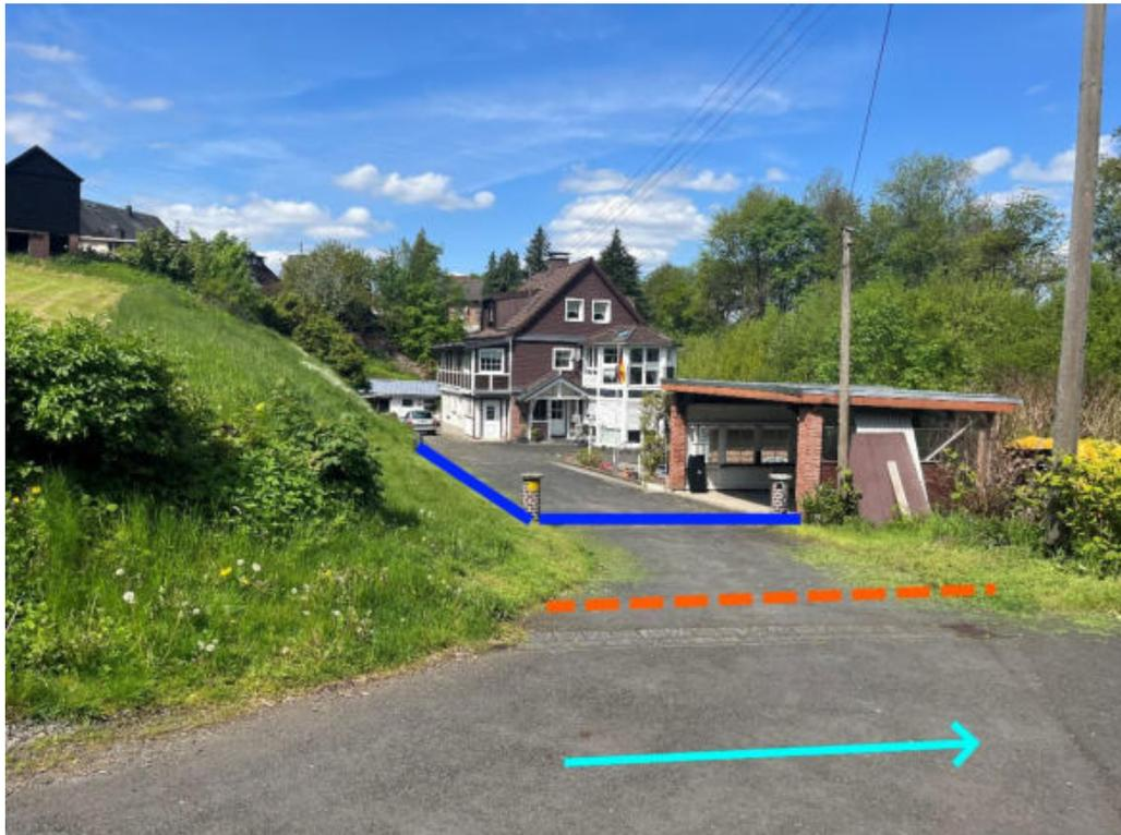
Abbildung 106: Notabflussweg "Ringstraße" mit Fließrichtung (hellblau), Objektschutzmaßnahmen (dunkelblau) und Aufwallung (orange)
