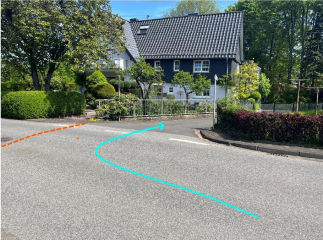
Abbildung 100: Notabflussweg "Ringstraße" mit Fließrichtung (hellblau) und Objektschutzmaßnahmen (dunkelblau)
