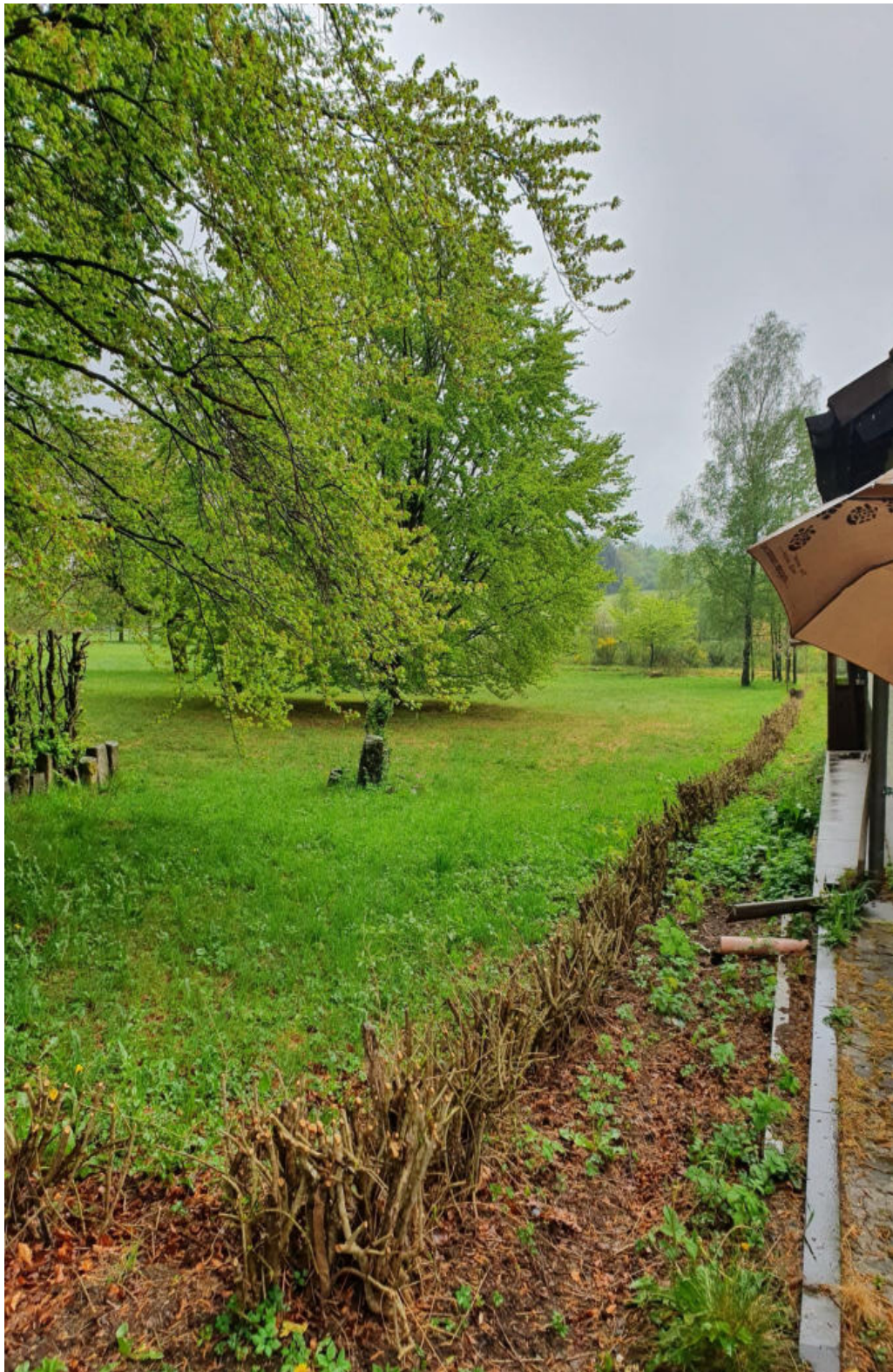
Abbildung 23: Kausen: Käuserstruth, Blick Richtung Außengebiet; Gefahrenpunkt 9.7
