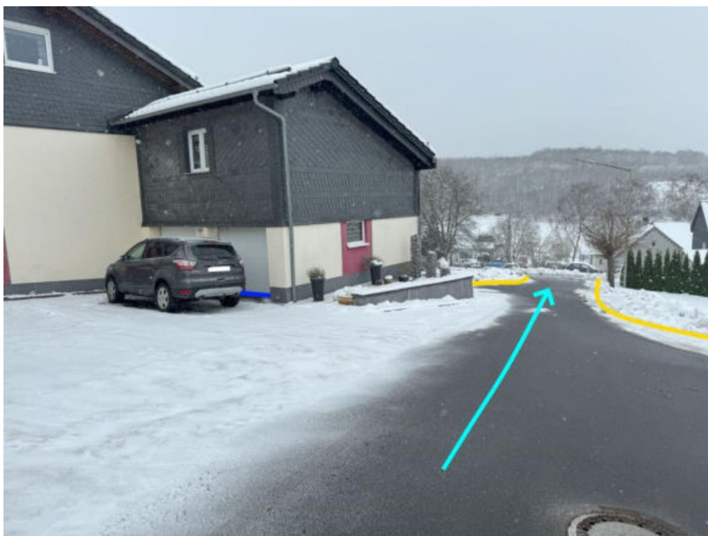
Abbildung 145: Notabflussweg "Rosenweg" mit Fließrichtung (hellblau), Objektschutzmaßnahmen (blau) und Bordanlagen (gelb)
