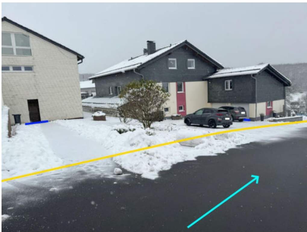
Abbildung 144: Notabflussweg "Rosenweg" mit Fließrichtung (hellblau), Objektschutzmaßnahmen (blau) und Bordanlagen (gelb)
