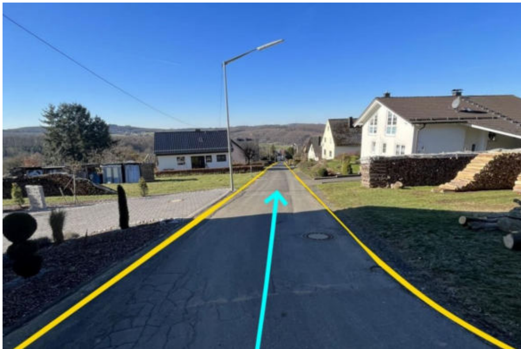
Abbildung 170: Notabflussweg "Bergstraße" mit Fließrichtung (hellblau), Objektschutzmaßnahmen (blau) und Bordanlagen (gelb)
