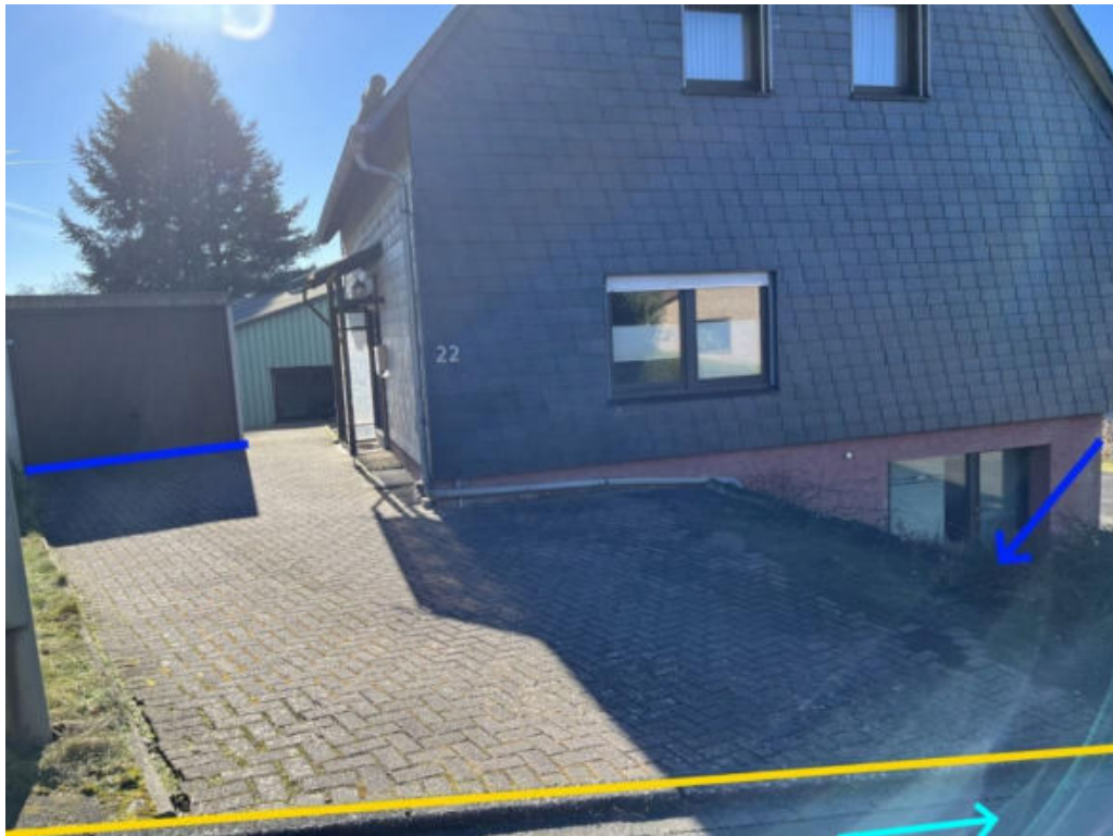
Abbildung 178: Notabflussweg "Bergstraße" mit Fließrichtung (hellblau), Objektschutzmaßnahmen (blau) und Bordanlagen (gelb)
