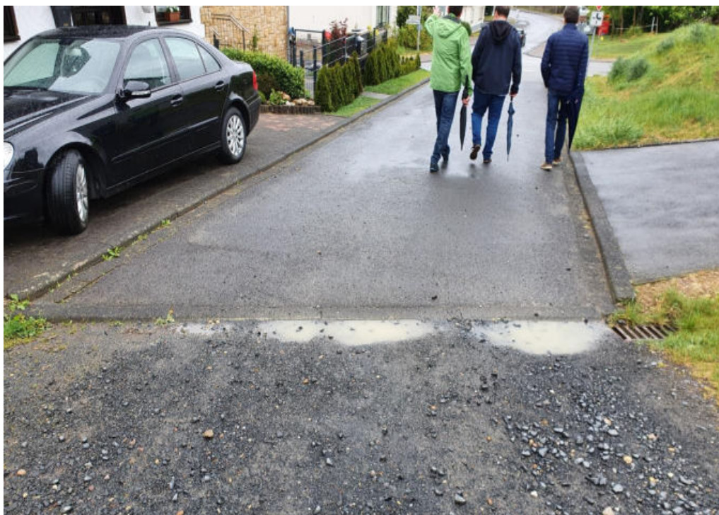
Abbildung 33: Kausen: Zulauf süd-östliches Außengebiet Richtung Auestraße; Gefahrenpunkt 9.3
