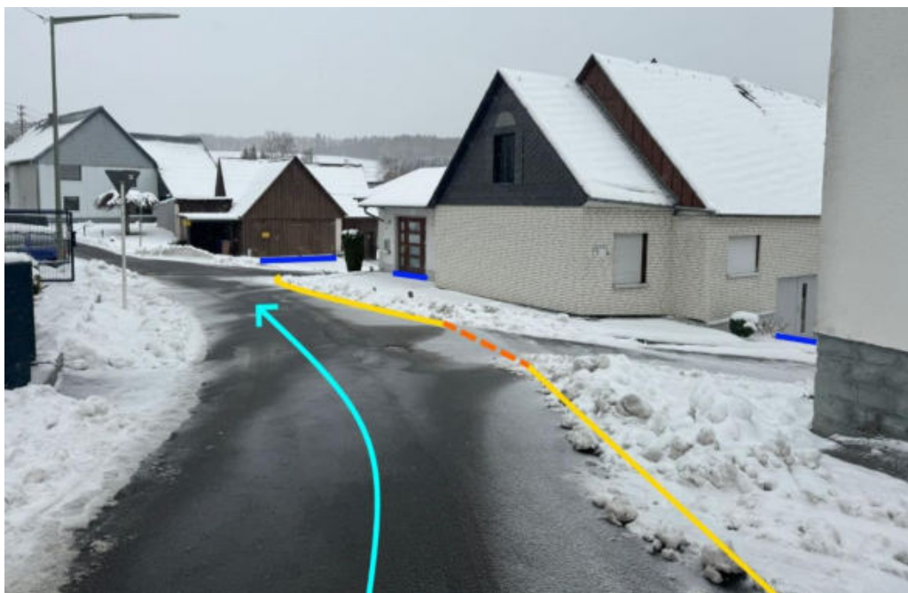
Abbildung 133: Notabflussweg "Grubenweg" mit Fließrichtung (hellblau), Aufwallung (orange) Objektschutzmaßnahmen (blau) und Bordanlagen (gelb)
