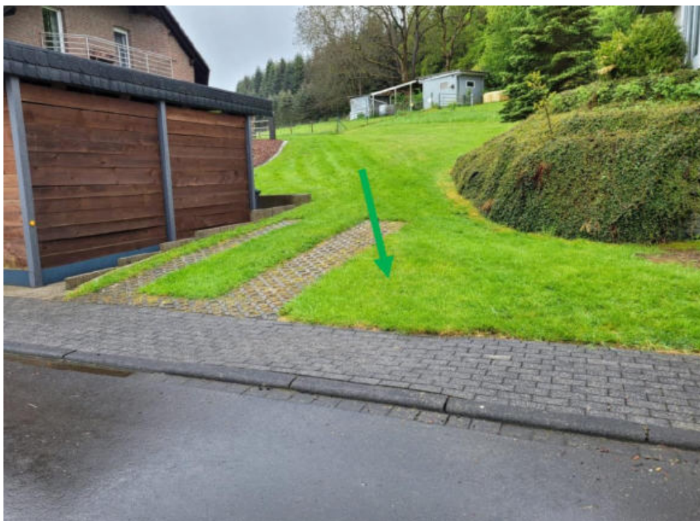
Abbildung 68: Zufluss von Oberflächenwasser auf die Verkehrsanlagen über die Grundstücksflächen zwischen Sportplatzweg 7 und 9; Gefahrenpunkt 9.18
