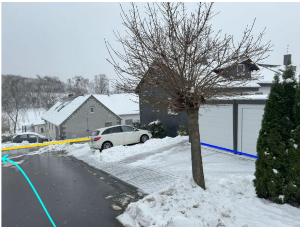
Abbildung 148: Notabflussweg "Rosenweg" mit Fließrichtung (hellblau), Objektschutzmaßnahmen (blau) und Bordanlagen (gelb)
