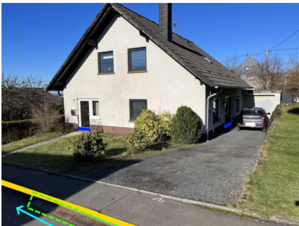
Abbildung 175: Notabflussweg "Bergstraße" mit Fließrichtung (hellblau), Objektschutzmaßnahmen (blau) und Bordanlagen (gelb)
