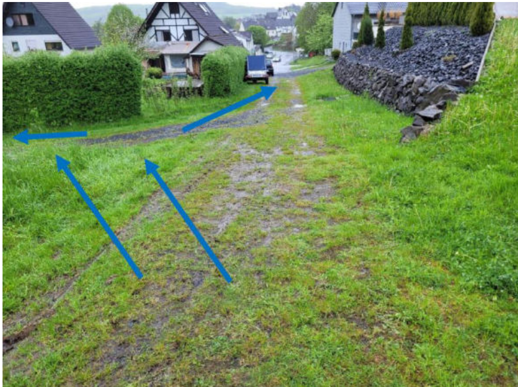
Abbildung 73: Zufluss von Oberflächenwasser aus dem Außengebiet in Richtung Sportplatzweg Nr. 1 und Nr.3 und Weg östlich Sportplatzweg Nr.1, Gefahrenpunkt 9.19
