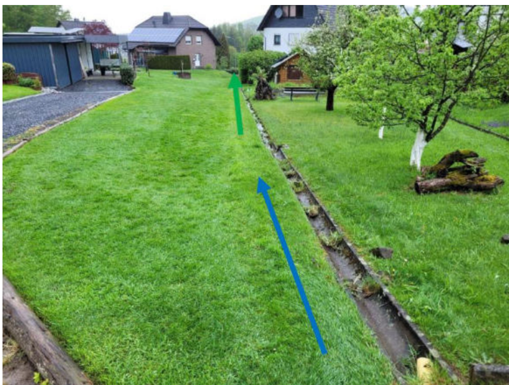
Abbildung 69: Zufluss von Oberflächenwasser auf die Verkehrsanlagen über die Grundstücksflächen zwischen Sportplatzweg 5 und 3; Gefahrenpunkt 9.18
