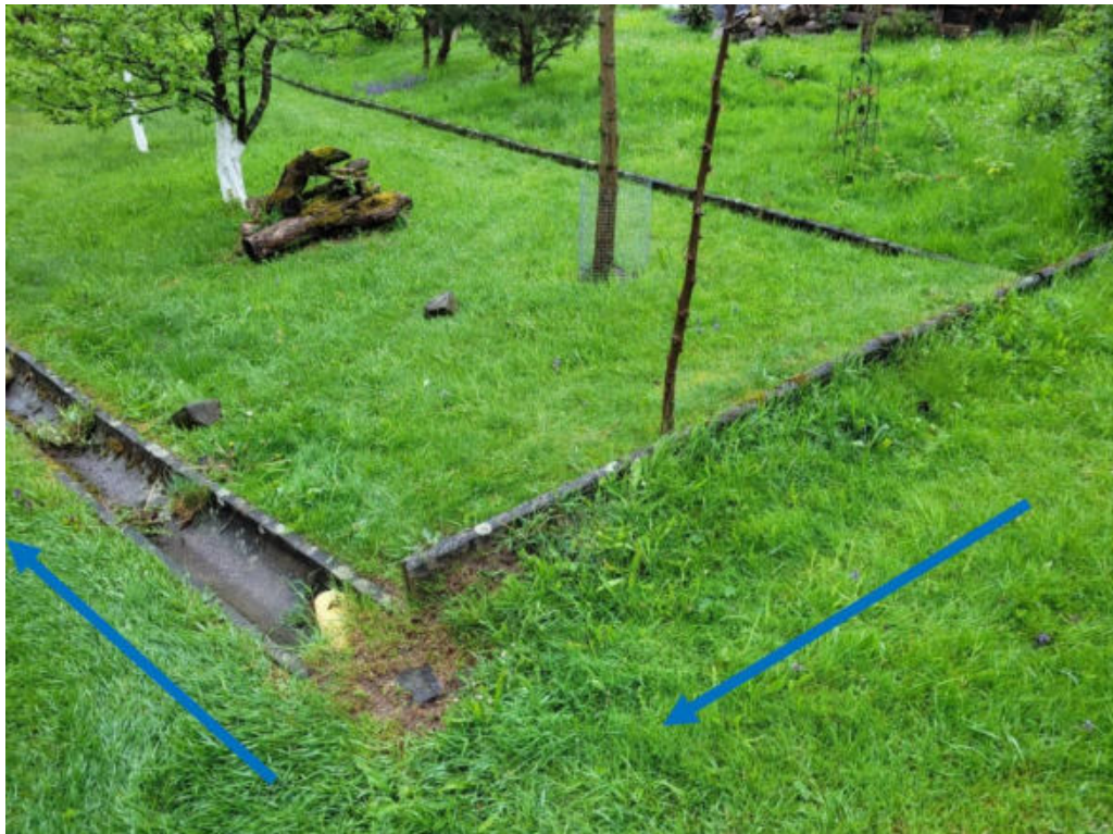
Abbildung 71: Oberflächenabfluss wird über Randsteine und Rinne auf Grundstück Sportplatzweg 3 gelenkt
