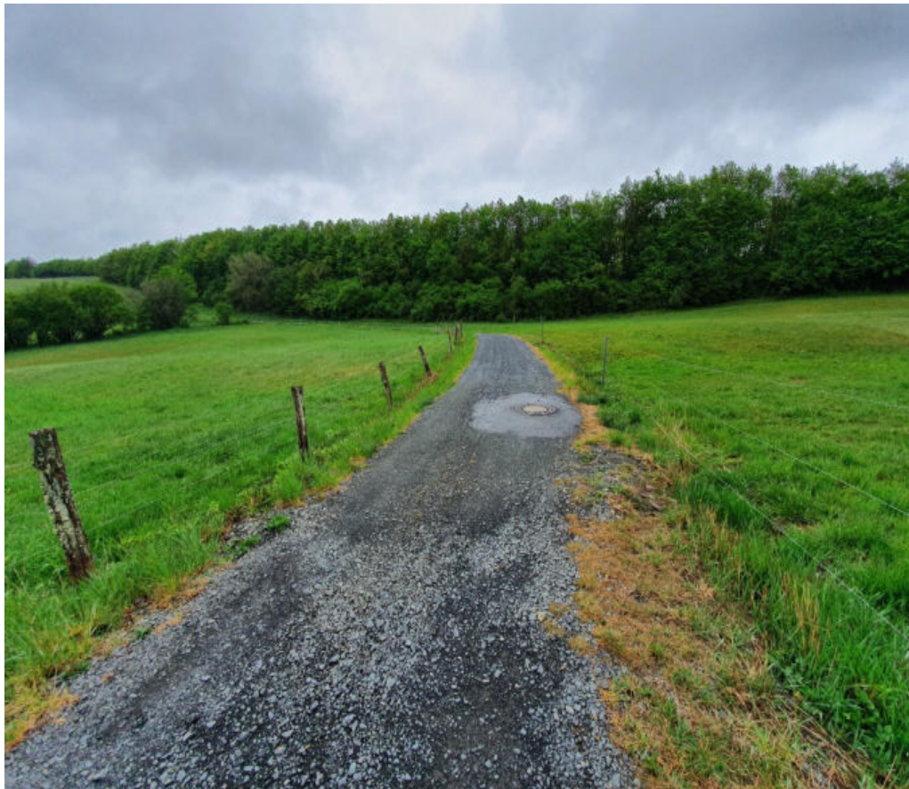
Abbildung 19: Kausen: Wirtschaftsweg Richtung Austraße/K118, Blick Richtung L288; Gefahrenpunkt 9.5
