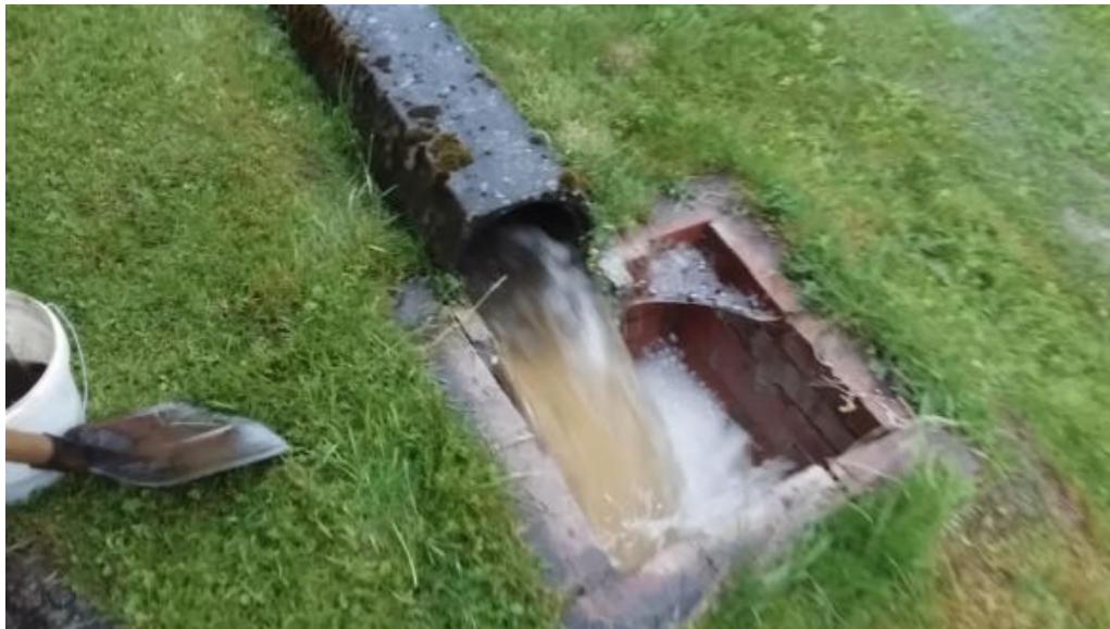
Abbildung 37: Starkregen Kausen 25.06.2016: Oberflächenabfluss über private Grundstücke hier Einlauf in Verrohrung; Gefahrenpunkt 9.3
