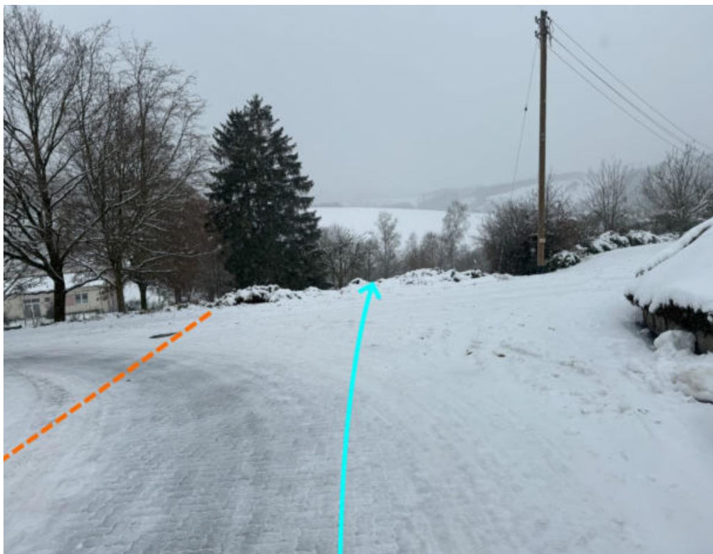
Abbildung 123: Notabflussweg "Neue Straße" mit Fließrichtung (hellblau) und Aufwallung (orange)
