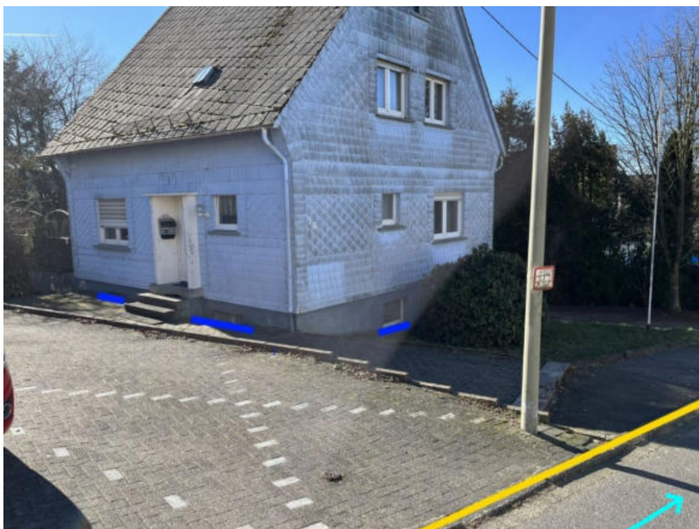
Abbildung 185: Notabflussweg "Bergstraße" mit Fließrichtung (hellblau), Objektschutzmaßnahmen (blau) und Bordanlagen (gelb)
