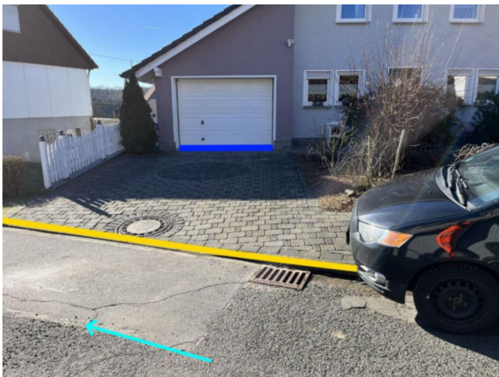
Abbildung 169: Notabflussweg "Ulmenweg" mit Fließrichtung (hellblau), Objektschutzmaßnahmen (blau) und Bordanlagen (gelb)
