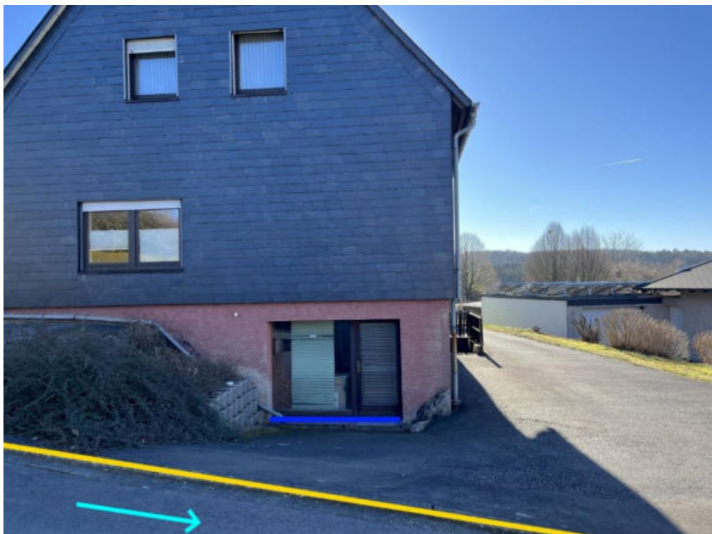
Abbildung 179: Notabflussweg "Bergstraße" mit Fließrichtung (hellblau), Objektschutzmaßnahmen (blau) und Bordanlagen (gelb)
