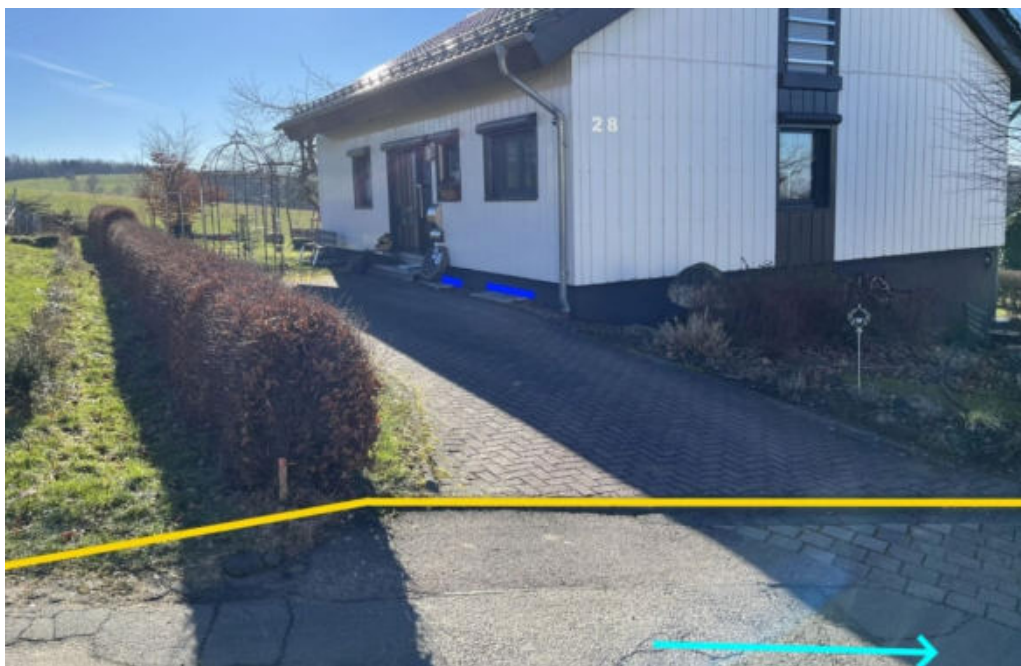
Abbildung 171: Notabflussweg "Bergstraße" mit Fließrichtung (hellblau), Objektschutzmaßnahmen (blau) und Bordanlagen (gelb)
