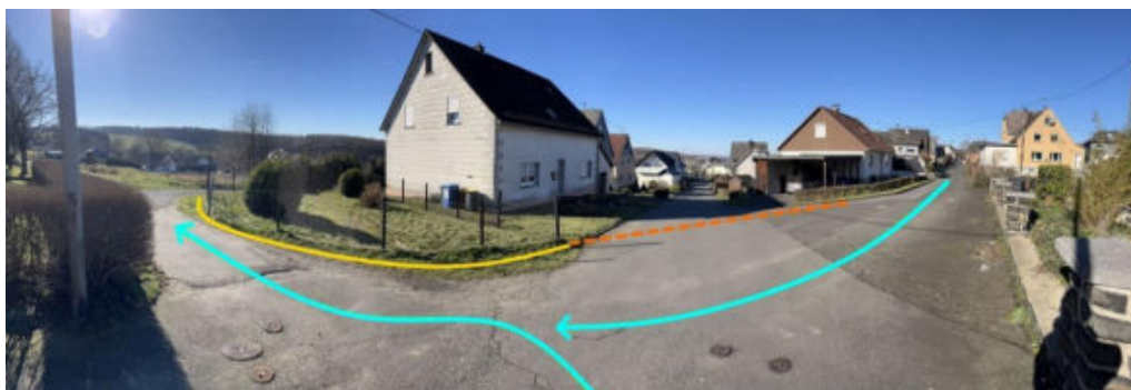
Abbildung 188: Notabflussweg "Bergstraße" mit Fließrichtung (hellblau), Objektschutzmaßnahmen (blau) und Bordanlagen (gelb)
