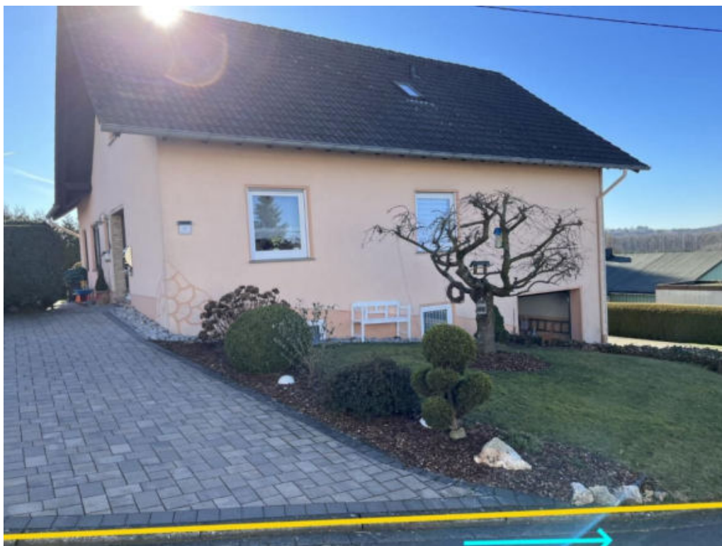
Abbildung 176: Notabflussweg "Bergstraße" mit Fließrichtung (hellblau), Objektschutzmaßnahmen (blau) und Bordanlagen (gelb)
