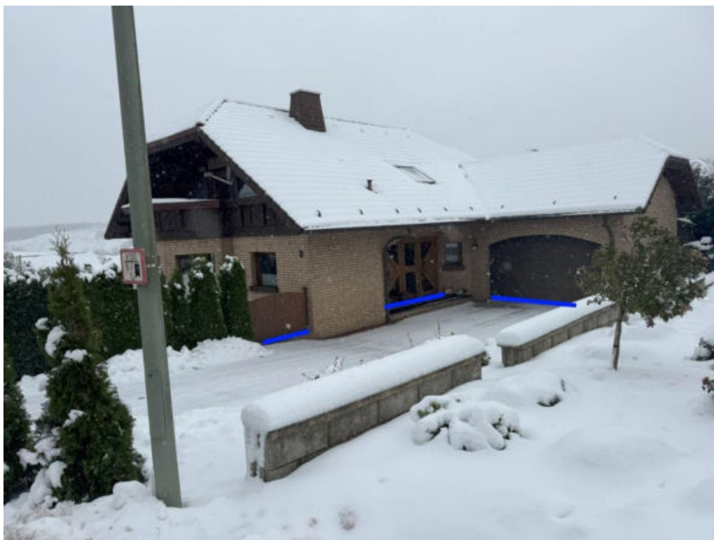
Abbildung 142: Notabflussweg "Rosenweg" mit Objektschutzmaßnahmen (blau)
