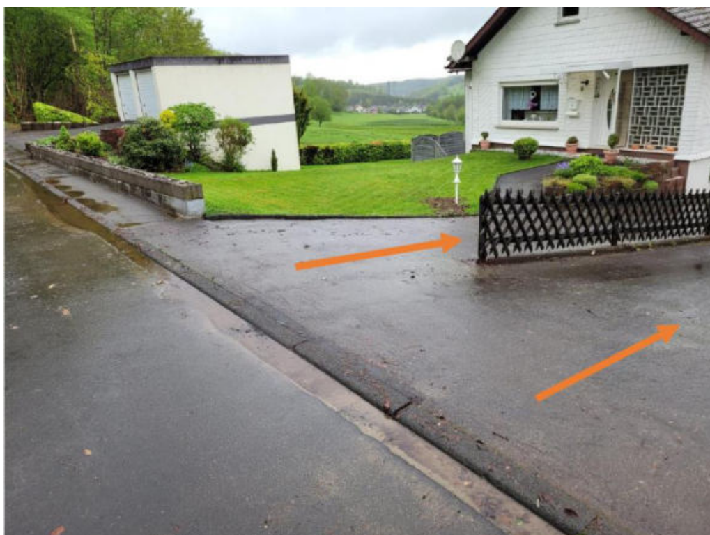
Abbildung 65: Übertretendes Wasser auf die Grundstücke im Bereich der Senke vor Sportplatzweg 8 Gefahrenpunkt 9.1 und 9.2
