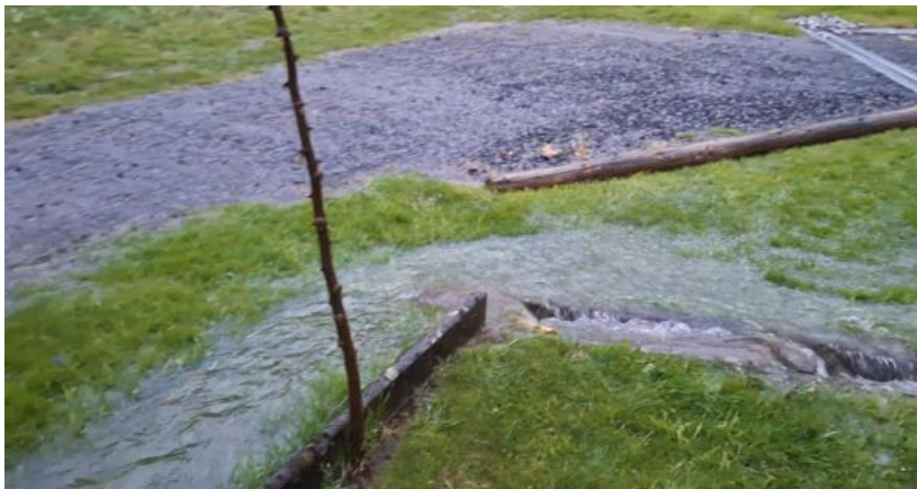
Abbildung 72: Oberflächenabfluss wird über Randsteine und Rinne auf Grundstück Sportplatzweg 3 gelenkt (Aufnahme während dem Ereignis)
