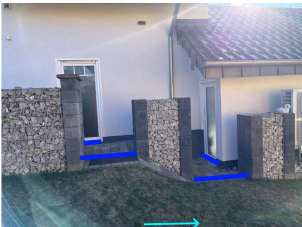
Abbildung 191: Notabflussweg "Bergstraße" mit Fließrichtung (hellblau), Objektschutzmaßnahmen (blau) und Bordanlagen (gelb)
