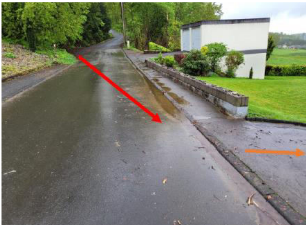
Abbildung 64: Übertretendes Wasser auf die Grundstücke im Bereich der Senke vor Sportplatzweg 8 Gefahrenpunkt 9.1
