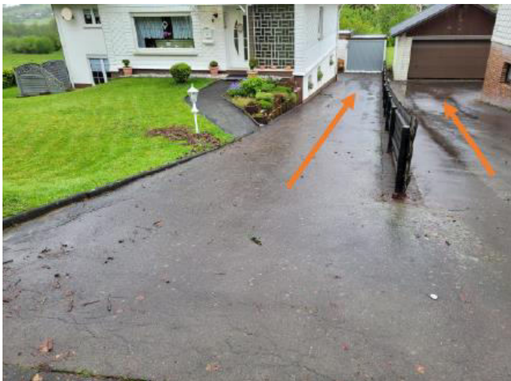
Abbildung 66: Übertretendes Wasser auf die Grundstücke im Bereich der Senke vor Sportplatzweg 8 Gefahrenpunkt 9.1 und 9.2
