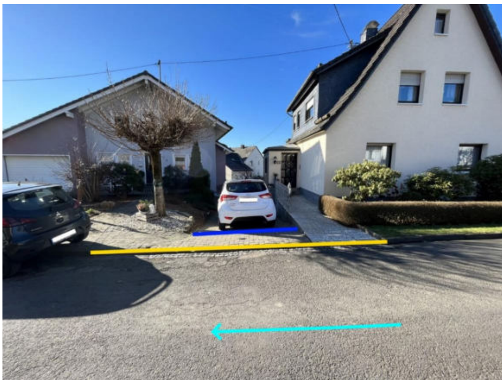
Abbildung 168: Notabflussweg "Ulmenweg" mit Fließrichtung (hellblau), Objektschutzmaßnahmen (blau) und Bordanlagen (gelb)
