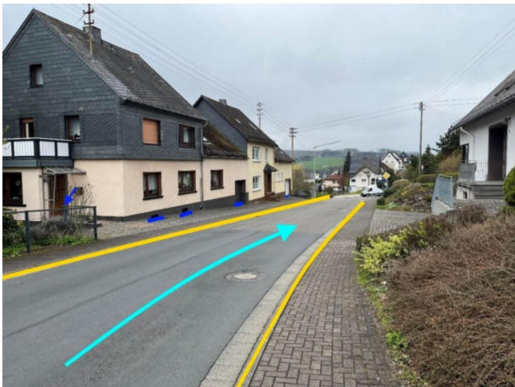
Abbildung 88: Notfließweg „Bindweider Straße“ mit Fließrichtung (hellblau), Objektschutzmaßnahmen (dunkelblau) und Bordanlagen (gelb)
