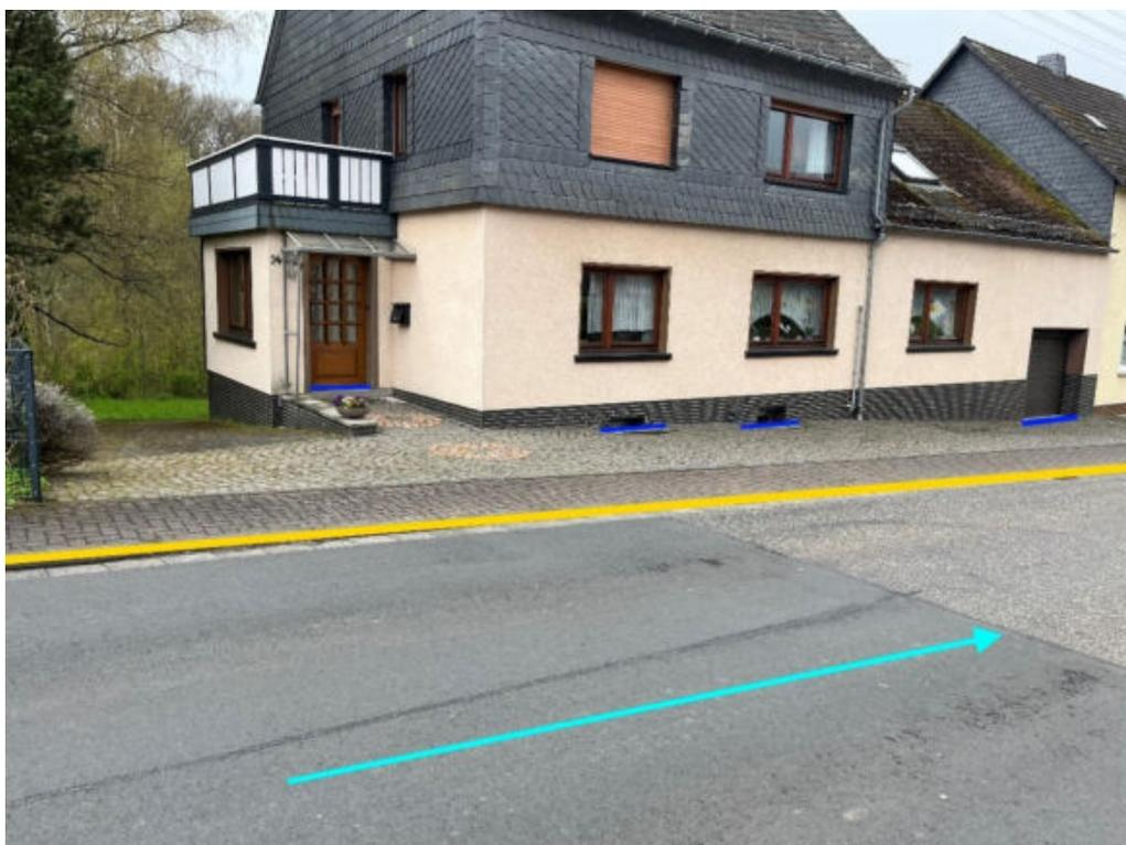
Abbildung 89: Notfließweg „Bindweider Straße“ mit Fließrichtung (hellblau), Objektschutzmaßnahmen (dunkelblau) und Bordanlagen (gelb)
