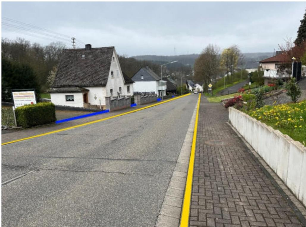
Abbildung 95: Notfließweg „Bindweider Straße“ mit Fließrichtung (hellblau), Objektschutzmaßnahmen (dunkelblau) und Bordanlagen (gelb)
