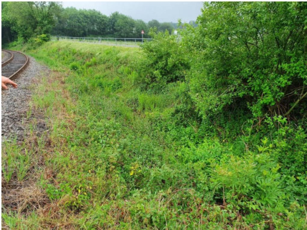
Abbildung 47: Entwässerungsgraben entlang der Bahn
