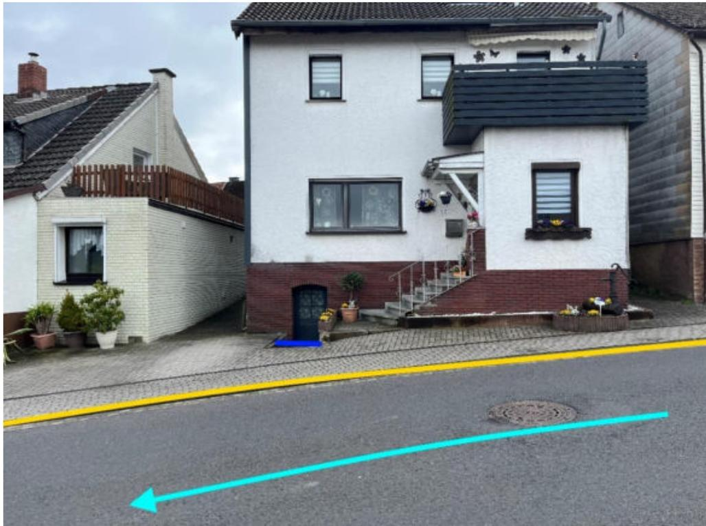
Abbildung 133: Notfließweg „Hahnwallstraße“ mit Fließrichtung (hellblau), Objektschutzmaßnahmen (dunkelblau) und Bordanlagen (gelb)
