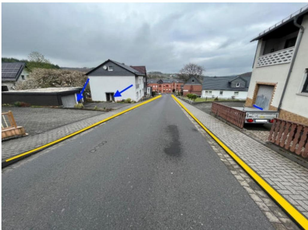
Abbildung 136: Notfließweg „Hahnwallstraße“ mit Fließrichtung (hellblau), Objektschutzmaßnahmen (dunkelblau) und Bordanlagen (gelb)
