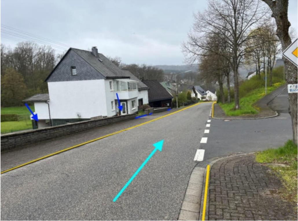
Abbildung 99: Notfließweg „Bindweider Straße“ mit Fließrichtung (hellblau), Objektschutzmaßnahmen (dunkelblau) und Bordanlagen (gelb)
