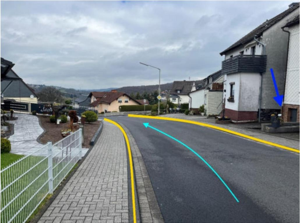
Abbildung 131: Notfließweg „Hahnwallstraße“ mit Fließrichtung (hellblau), Objektschutzmaßnahmen (dunkelblau) und Bordanlagen (gelb)
