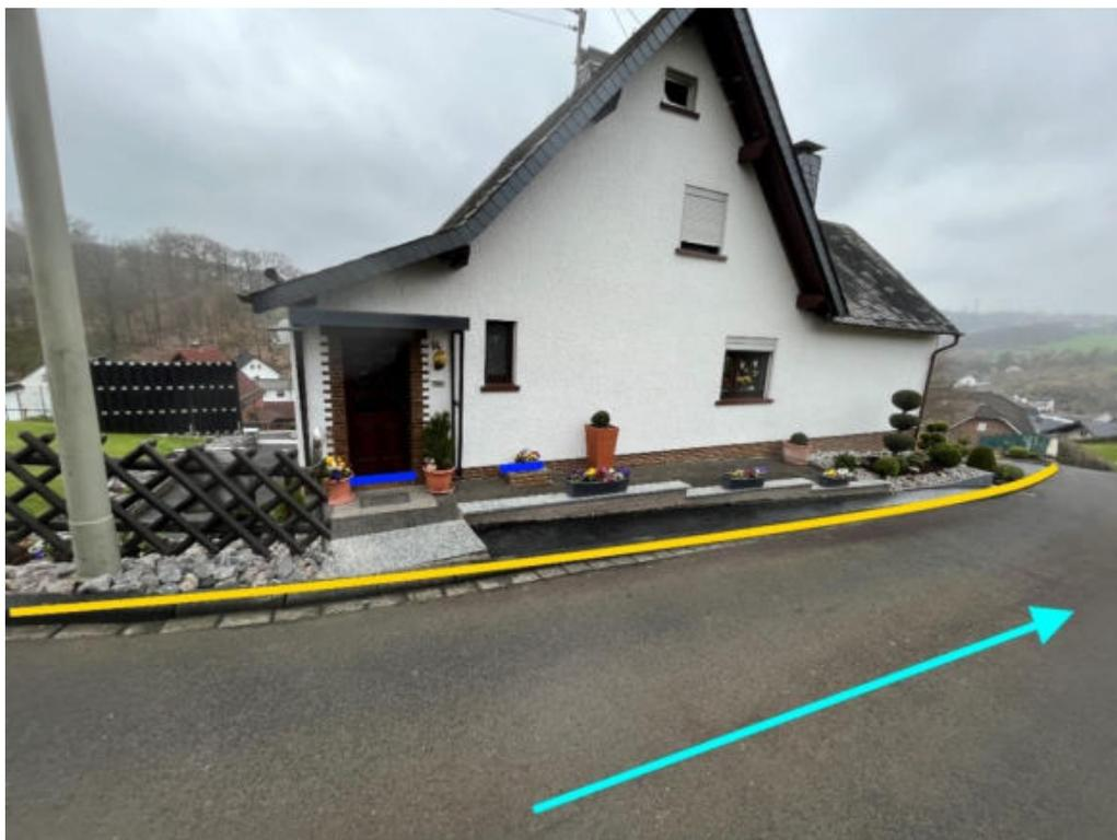
Abbildung 195: Notfließweg „Bergstraße" mit Fließrichtung (hellblau), Objektschutzmaßnahmen (dunkelblau) und Bordanlagen (gelb)
