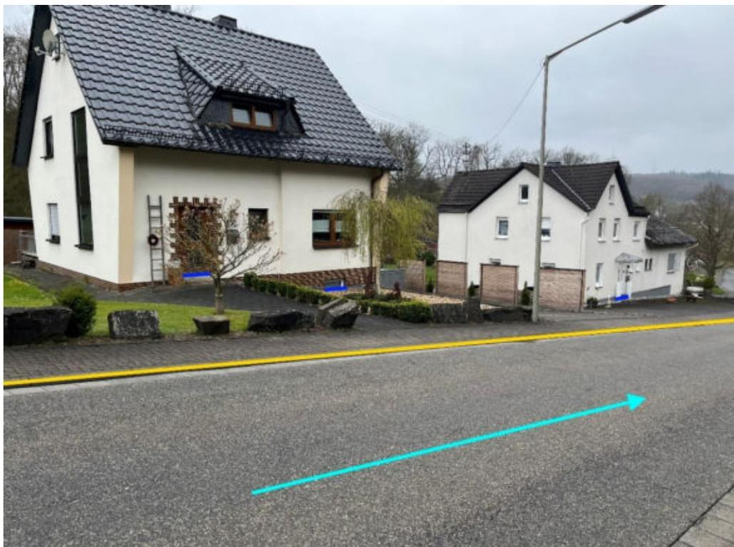
Abbildung 107: Notfließweg „Bindweider Straße“ mit Fließrichtung (hellblau), Objektschutzmaßnahmen (dunkelblau) und Bordanlagen (gelb)
