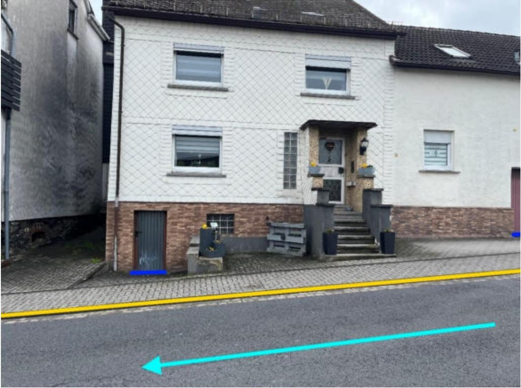
Abbildung 132: Notfließweg „Hahnwallstraße“ mit Fließrichtung (hellblau), Objektschutzmaßnahmen (dunkelblau) und Bordanlagen (gelb)
