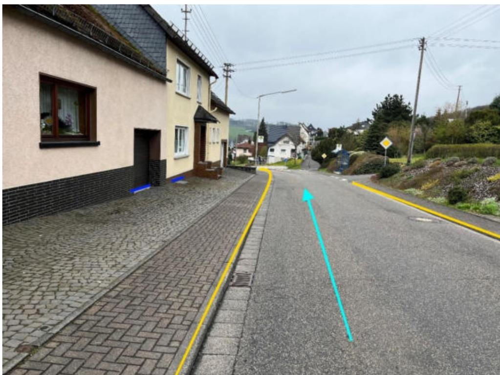
Abbildung 91: Notfließweg „Bindweider Straße“ mit Fließrichtung (hellblau), Objektschutzmaßnahmen (dunkelblau) und Bordanlagen (gelb)
