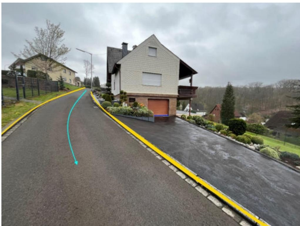
Abbildung 196: Notfließweg „Bergstraße" mit Fließrichtung (hellblau), Objektschutzmaßnahmen (dunkelblau) und Bordanlagen (gelb)
