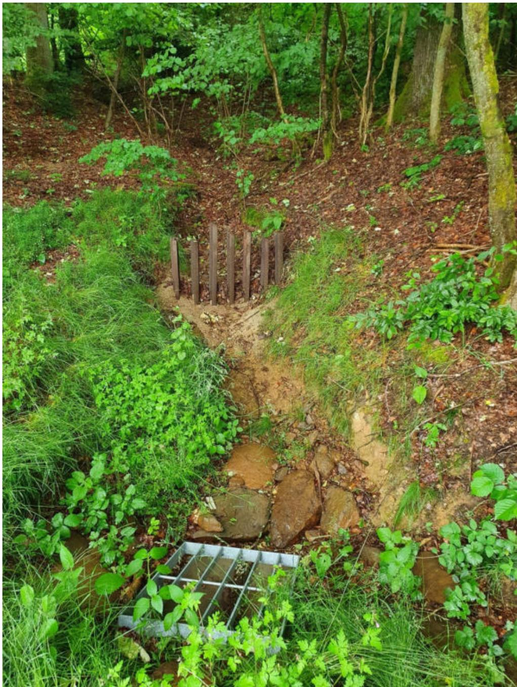
Abbildung 58: Einlauf Verrohrung Außengebietswasser Richtung Steinebach;
