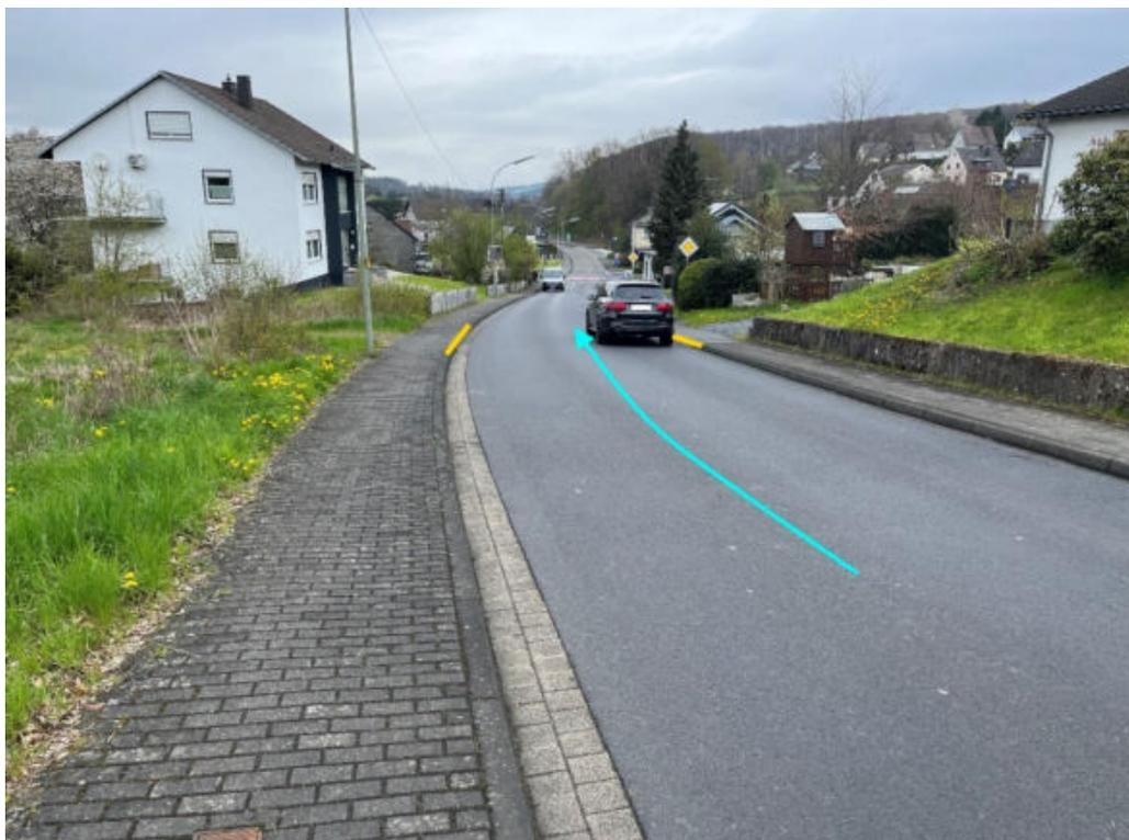
Abbildung 146: Notfließweg „Hauptstraße“ mit Fließrichtung (hellblau), Objektschutzmaßnahmen (dunkelblau) und Bordanlagen (gelb)
