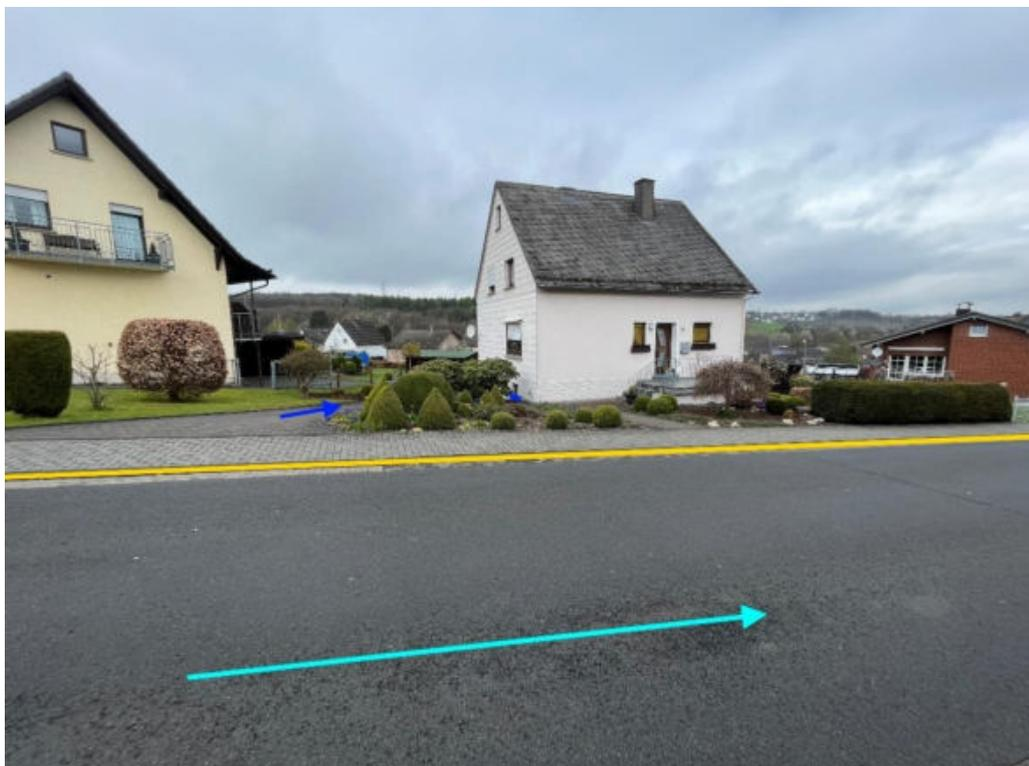
Abbildung 128: Notfließweg „Hahnwallstraße" mit Fließrichtung (hellblau), Objektschutzmaßnahmen (dunkelblau) und Bordanlagen (gelb)
