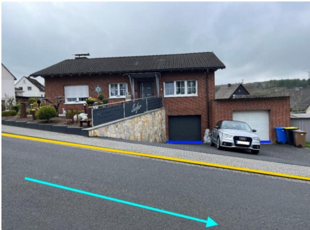
Abbildung 134: Notfließweg „Hahnwallstraße“ mit Fließrichtung (hellblau), Objektschutzmaßnahmen (dunkelblau) und Bordanlagen (gelb)
