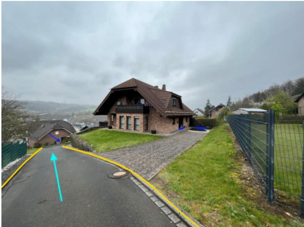
Abbildung 197: Notfließweg „Bergstraße“ mit Fließrichtung (hellblau), Objektschutzmaßnahmen (dunkelblau) und Bordanlagen (gelb)
