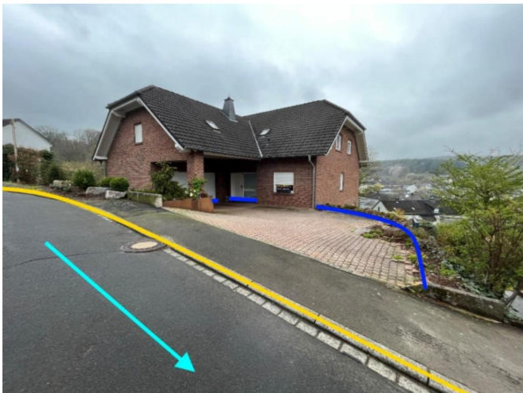
Abbildung 199: Notfließweg „Bergstraße“ mit Fließrichtung (hellblau), Objektschutzmaßnahmen (dunkelblau) und Bordanlagen (gelb)
