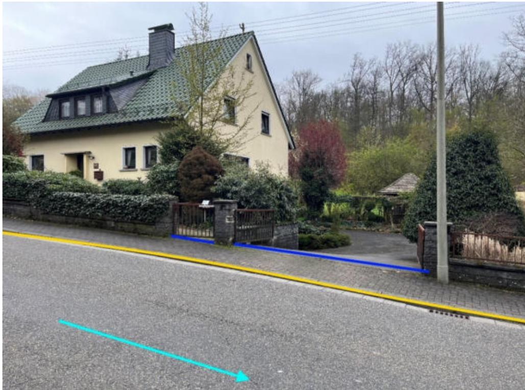
Abbildung 104: Notfließweg „Bindweider Straße“ mit Fließrichtung (hellblau), Objektschutzmaßnahmen (dunkelblau) und Bordanlagen (gelb)
