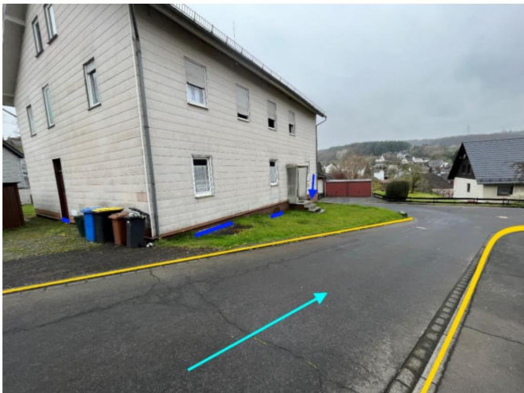
Abbildung 205: Notfließweg „Bergstraße“ mit Fließrichtung (hellblau), Objektschutzmaßnahmen (dunkelblau) und Bordanlagen (gelb)
