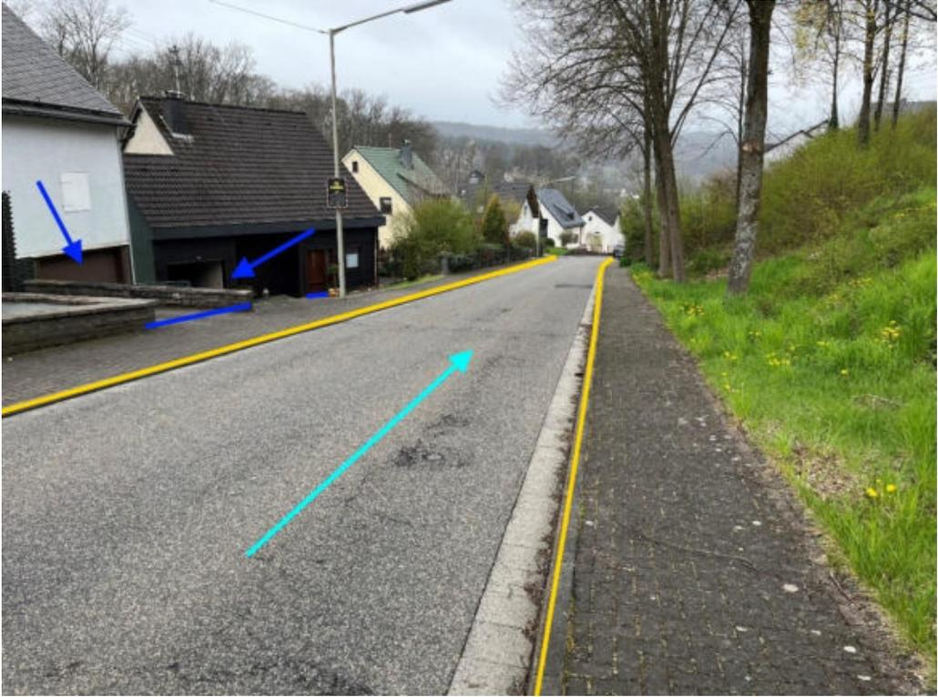
Abbildung 101: Notfließweg „Bindweider Straße“ mit Fließrichtung (hellblau), Objektschutzmaßnahmen (dunkelblau) und Bordanlagen (gelb)
