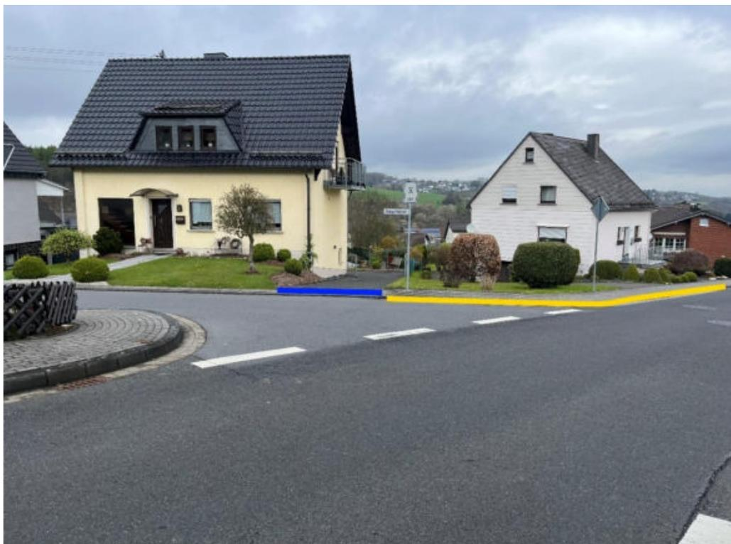
Abbildung 126: Notfließweg „Hahnwallstraße“ mit Fließrichtung (hellblau), Objektschutzmaßnahmen (dunkelblau) und Bordanlagen (gelb)
