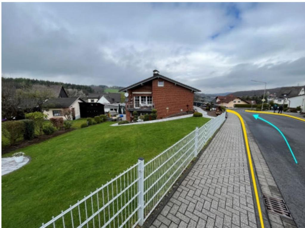
Abbildung 130: Notfließweg „Hahnwallstraße“ mit Fließrichtung (hellblau) und Bordanlagen (gelb)
