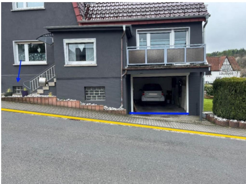
Abbildung 138: Notfließweg „Hahnwallstraße“ mit Fließrichtung (hellblau), Objektschutzmaßnahmen (dunkelblau) und Bordanlagen (gelb)
