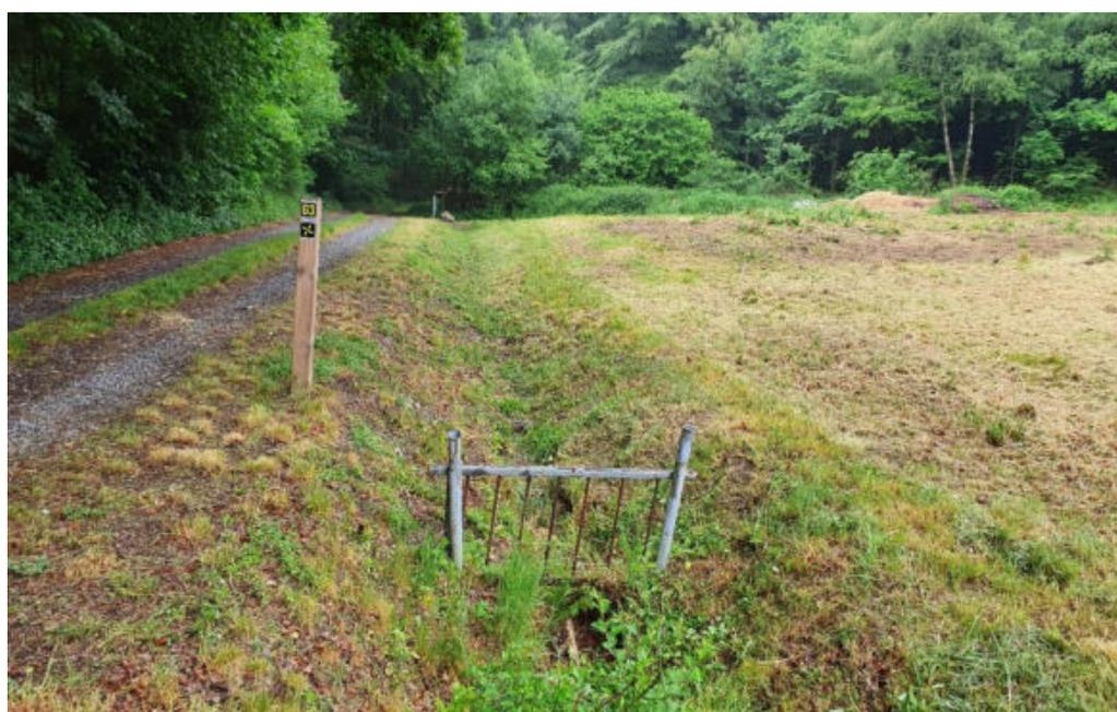
Abbildung 11: Einlauf Verrohrung mit Rechen am Niederseifen
