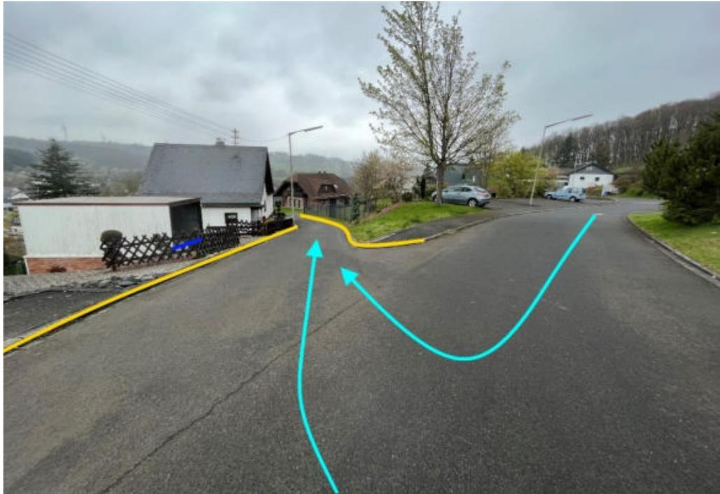
Abbildung 193: Notfließweg „Bergstraße“ mit Fließrichtung (hellblau), Objektschutzmaßnahmen (dunkelblau) und Bordanlagen (gelb)
