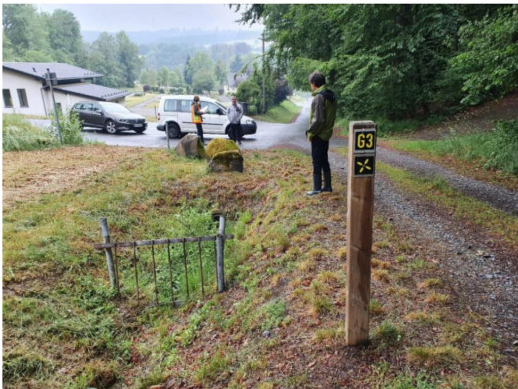
Abbildung 12: Einlauf Verrohrung mit Rechen am Niederseifen
