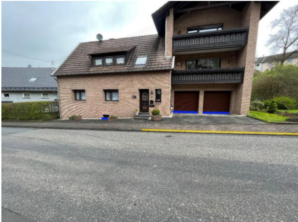
Abbildung 116: Notfließweg „Bindweider Straße“ mit Fließrichtung (hellblau), Objektschutzmaßnahmen (dunkelblau) und Bordanlagen (gelb)
