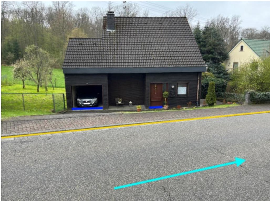
Abbildung 102: Notfließweg „Bindweider Straße“ mit Fließrichtung (hellblau), Objektschutzmaßnahmen (dunkelblau) und Bordanlagen (gelb)
