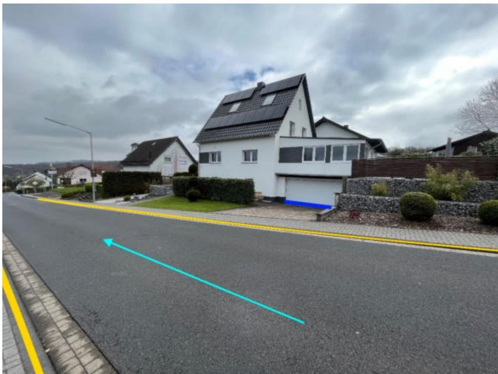
Abbildung 123: Notfließweg „Hahnwallstraße“ mit Fließrichtung (hellblau), Objektschutzmaßnahmen (dunkelblau) und Bordanlagen (gelb)
