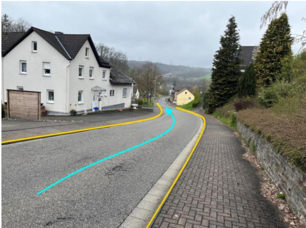
Abbildung 108: Notfließweg „Bindweider Straße“ mit Fließrichtung (hellblau), Objektschutzmaßnahmen (dunkelblau) und Bordanlagen (gelb)
