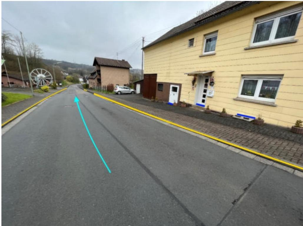
Abbildung 114: Notfließweg „Bindweider Straße“ mit Fließrichtung (hellblau), Objektschutzmaßnahmen (dunkelblau) und Bordanlagen (gelb)
