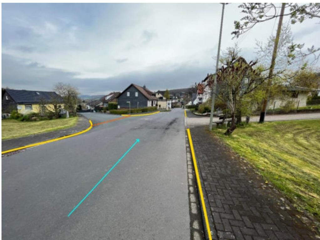
Abbildung 184: Notfließweg „Schwedengrabenstraße“ mit Fließrichtung (hellblau), Aufwallung (orange) und Bordanlagen (gelb)
