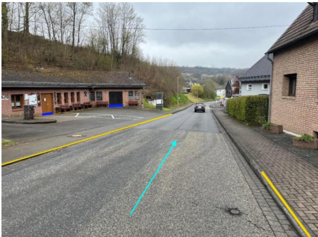
Abbildung 115: Notfließweg „Bindweider Straße“ mit Fließrichtung (hellblau), Objektschutzmaßnahmen (dunkelblau) und Bordanlagen (gelb)
