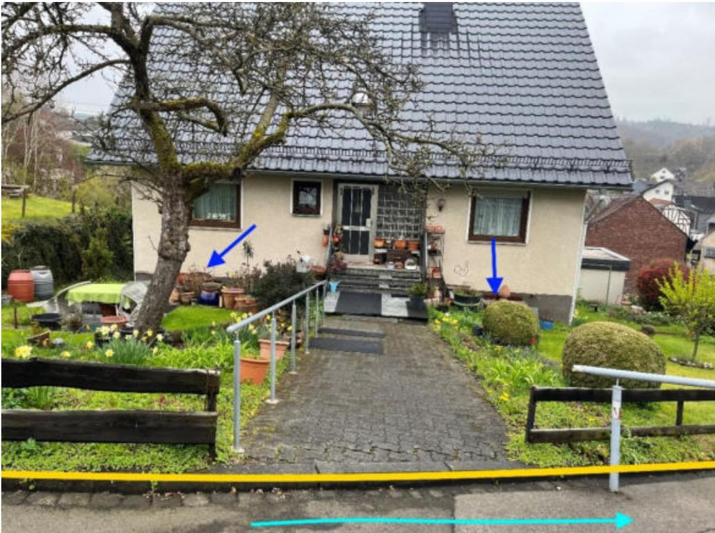
Abbildung 208: Notfließweg „Bergstraße“ mit Fließrichtung (hellblau), Objektschutzmaßnahmen (dunkelblau) und Bordanlagen (gelb)
