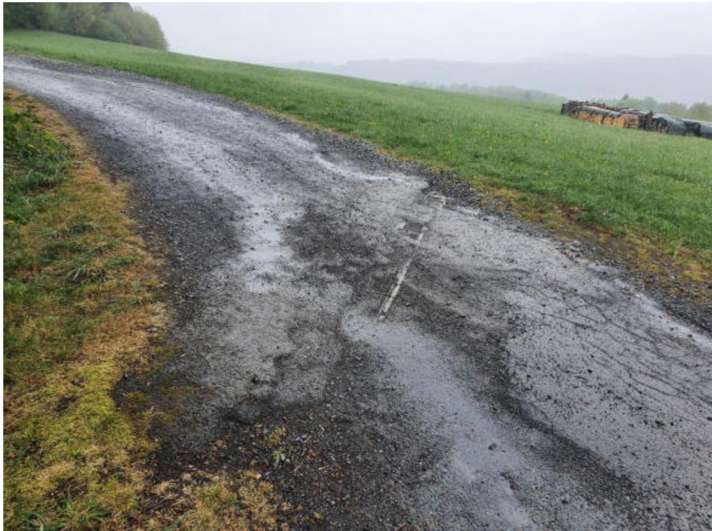
Abbildung 11 Steineroth, Zufluss von Außengebietswasser auf die Ortslage/zugesetzter Abschlag im Weg; Gefahrenpunkt 12.4
