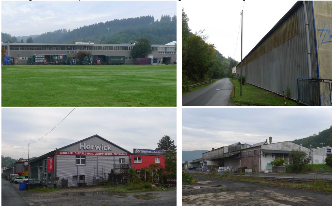
Abbildung 14: Beispiele für Produktions- und Lagerhallen/ Betriebsgebäude
